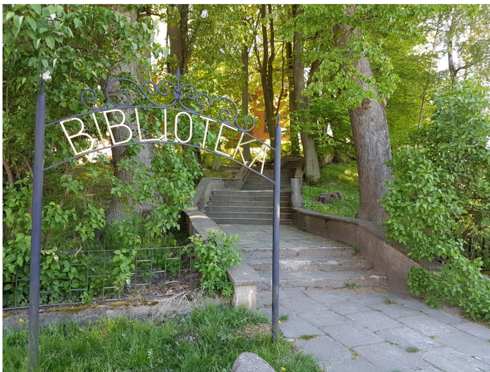
Widok schodów zewnętrznych – dojścia do budynku od strony północnej
