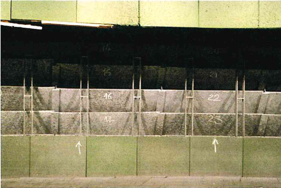
Fot. 2 Widok fragmentów łapacza pocisków po zdemontowaniu płyt tłumika rykoszetów – płyty stalowe od nr 14 do nr 23. Białe strzałki wskazują kierunek strzelania z poszczególnych stanowisk strzeleckich do ustawianych celów stałych
