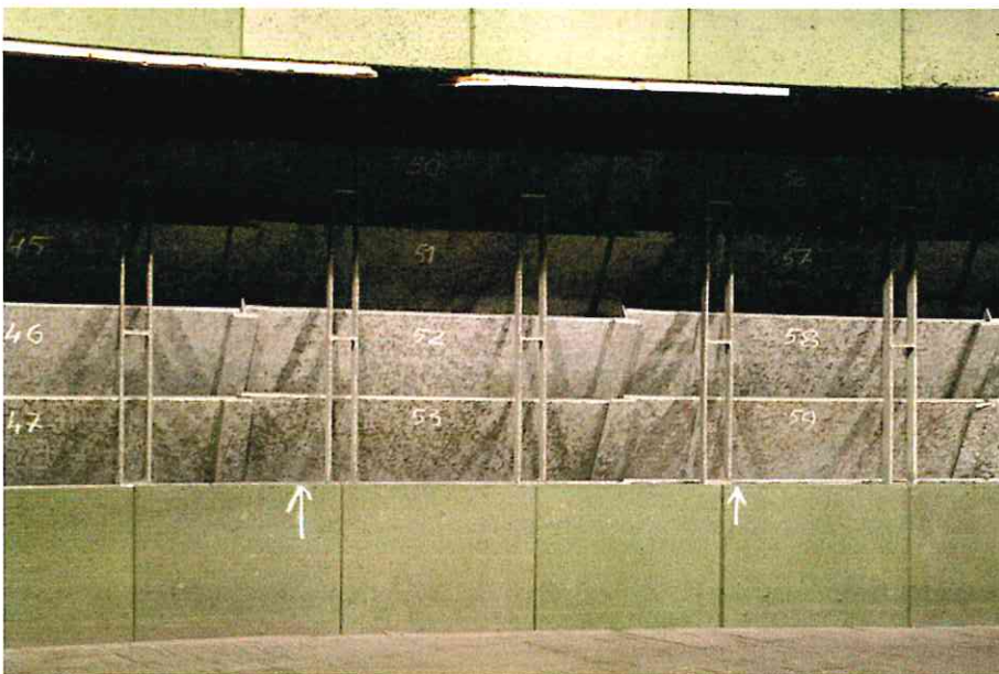
Fot. 5 Widok fragmentów łapacza pocisków po zdemontowaniu płyt tłumika rykoszetów – płyty stalowe od nr 44 do nr 59. Białe strzałki wskazują kierunek strzelania z poszczególnych stanowisk strzeleckich do ustawianych celów stałych
