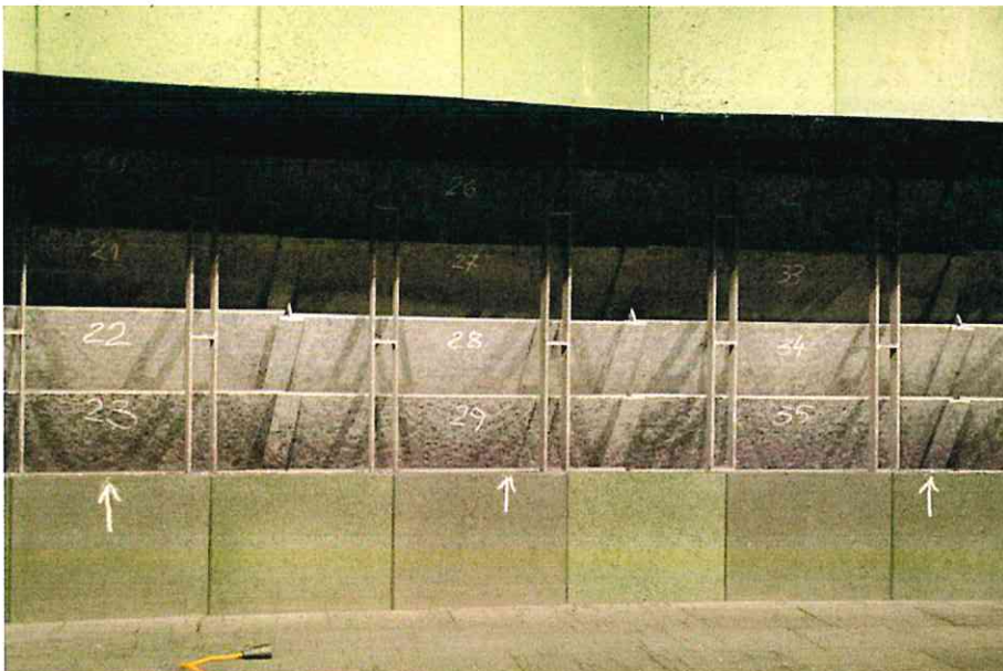
Fot. 3 Widok fragmentów łapacza pocisków po zdemontowaniu płyt tłumika rykoszetów – płyty stalowe od nr 20 do nr 35. Białe strzałki wskazują kierunek strzelania z poszczególnych stanowisk strzeleckich do ustawianych celów stałych
