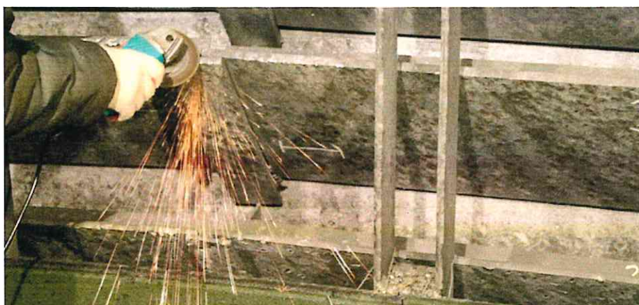
Fot.17 Próba iskrowa górnej krawędzi płyty
