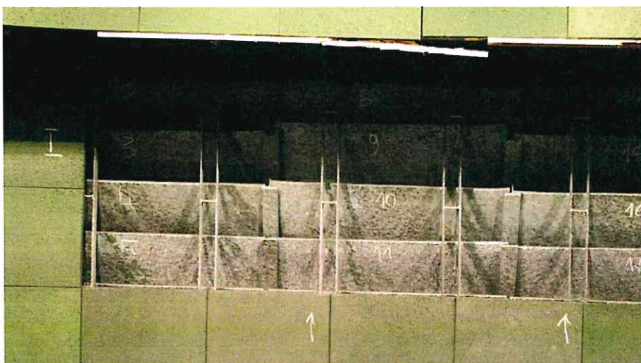
Fot. 1 Widok fragmentów łapacza pocisków po zdemontowaniu płyt tłumika rykoszetów – płyty stalowe od nr 1 do nr 17. Białe strzałki wskazują kierunek strzelania z poszczególnych stanowisk strzeleckich do ustawianych celów stałych
