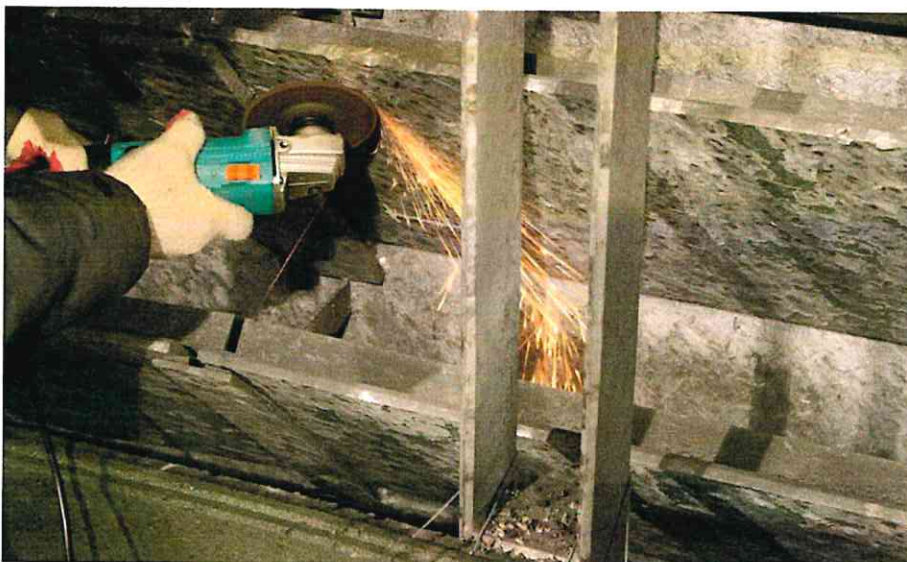
Fot.18 Próba iskrowa na czołowej płaszczyźnie płyty
