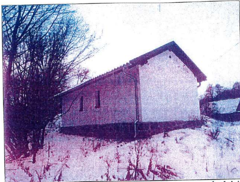
Widok elewacji budynku gospodarczego od strony wschodniej
