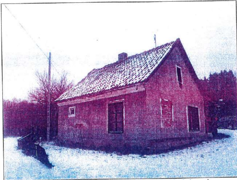
Widok elewacji budynku od strony południowej
