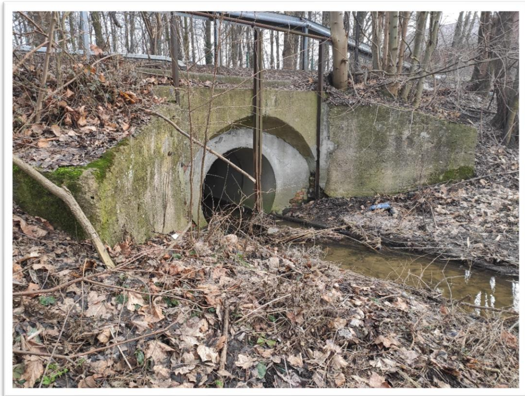
Fotografia 1. Wlot do przepustu pod ul. Powstańców Śląskich
