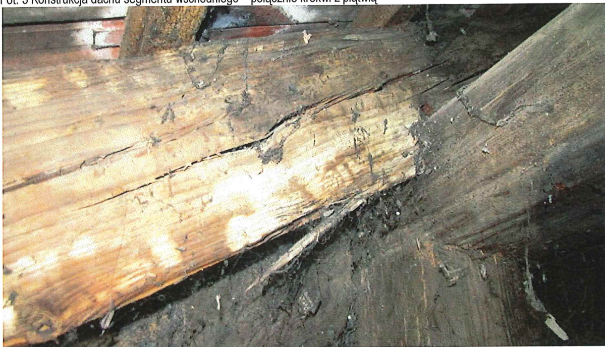
Fot. 3 Konstrukcja dachu segmentu wschodniego – połączenie krokwi z płatwią
