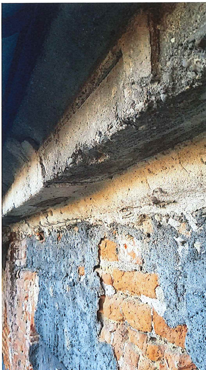
Fot. 9 Segment zachodni – gzyms betonowy
