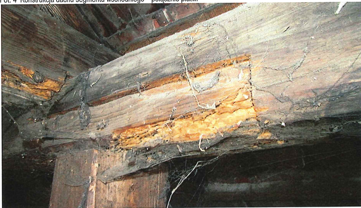
Fot. 4 Konstrukcja dachu segmentu wschodniego – połączenie płatwi
