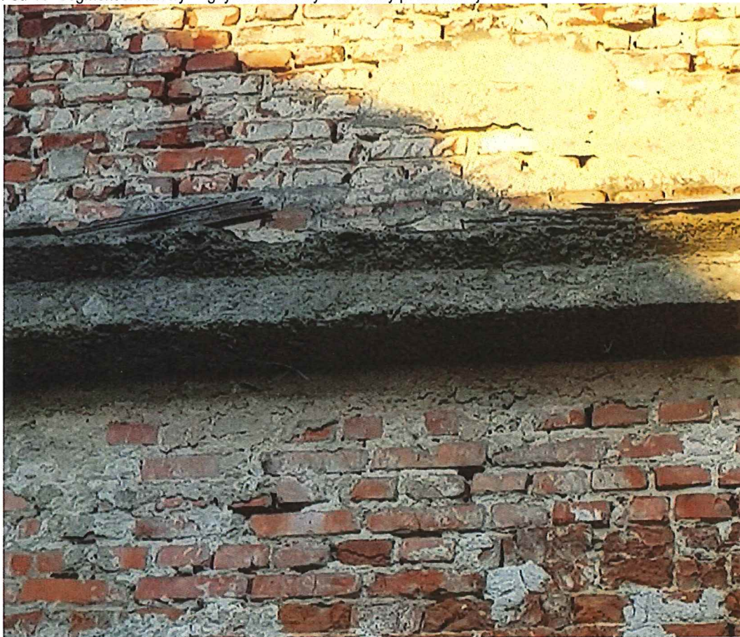
Fot. 10 Segment środkowy – gzyms betonowy od strony południowej.
