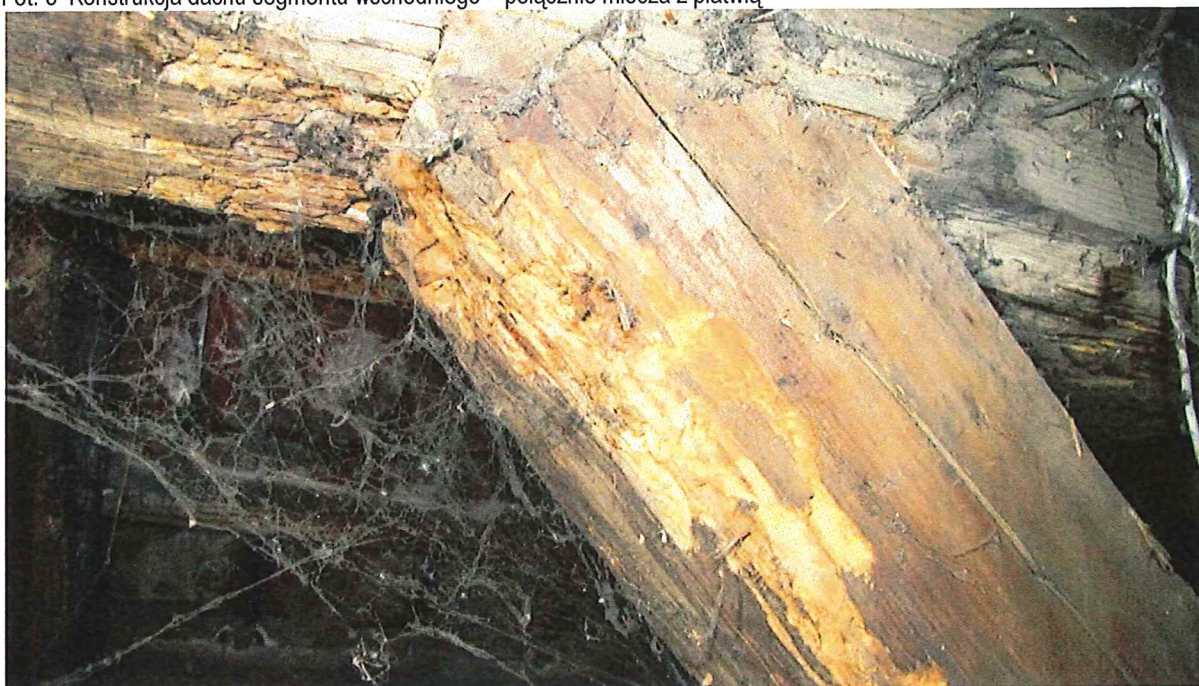
Fot. 5 Konstrukcja dachu segmentu wschodniego – połączenie miecza z płatwią
