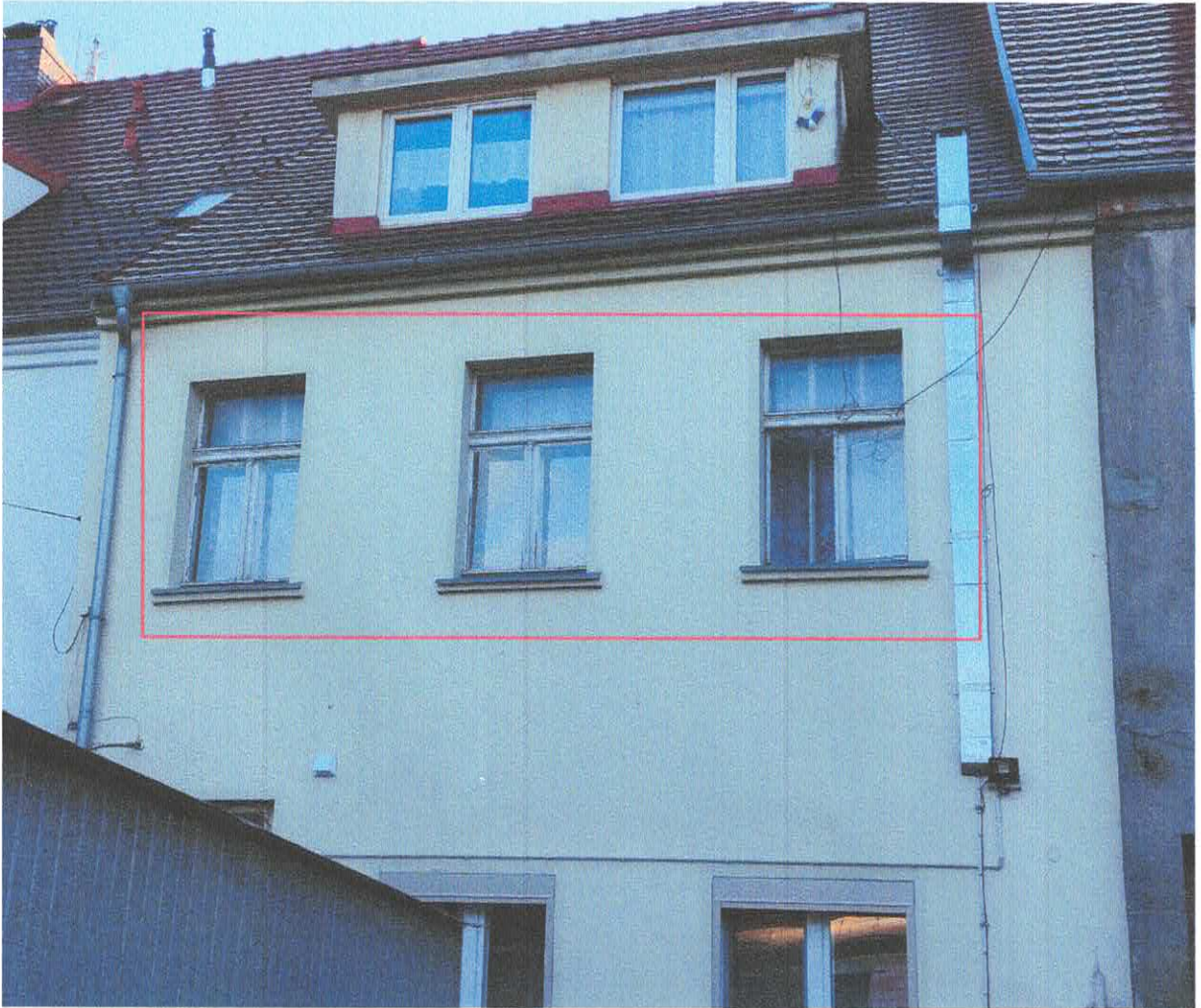
Fot. 1 – stolarka okienna przeznaczona do wymiany – widok od strony tylnej elewacji
