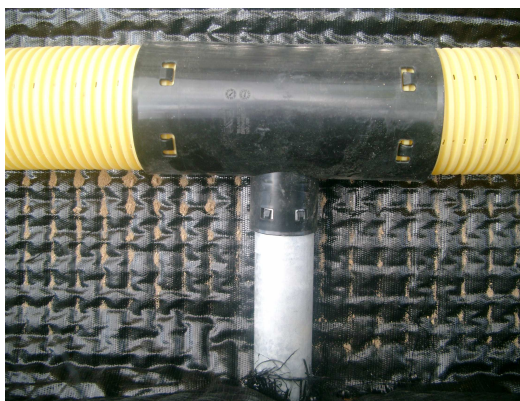
Rysunek 6 Połączenie rury drenażowej \Phi 100 mm z rurką \Phi 50 mm
