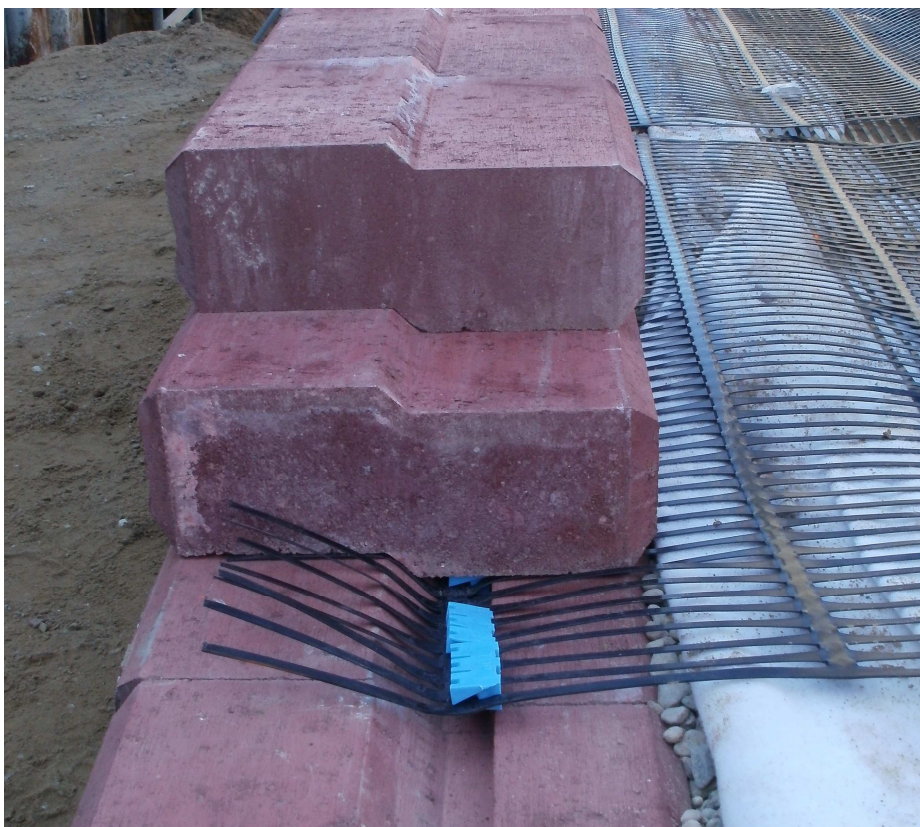
Rysunek 3. Mocowanie georusztu i łącznika
