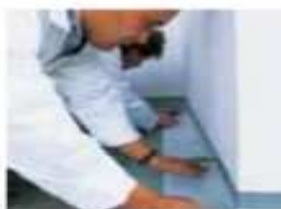
3 Przyłożyć włókninę Triflex (Spezialvlies) usuwając spod niej powietrze, a następnie...
