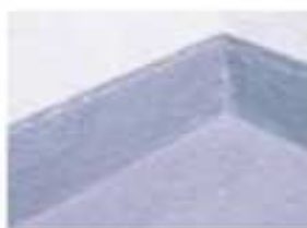
11 Podłoga balkonu jest gotowa w ciągu jednego dnia.
