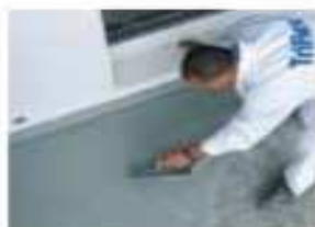
6 ... rozprowadzić za pomocą kielni i ...
