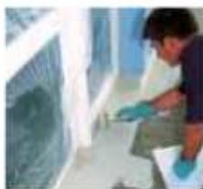
3 Najpierw uszczelnić detale za pomocą Triflex ProDetail.
