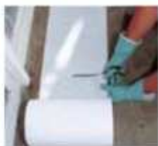
2 Przygotować wykroje z włókniny Triflex (Spezialvlies).
