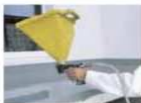
10 ... wdmuchać na nią Triflex Micro Chips.
