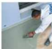
11 ... rozprowadzić za pomocą kielni i wygładzić.
