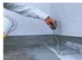
4 ... ponownie nałożyć grubą warstwę Triflex ProDetail.
