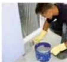
12 Położyć powłokę utrwalającą Triflex Ceryl Finish 205 i ...
