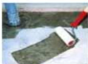
1 Zagruntować łączenie ze ścianą i całą powierzchnię.
