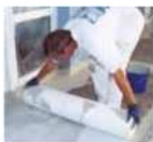
8 Przyłożyć włókninę Triflex (Spezialvlies) całą powierzchnią, usuwając spod niej powietrze.
