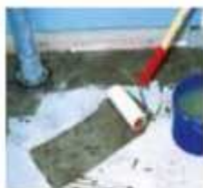
1 Zagruntować łączenie ze ścianą i całą powierzchnię.
