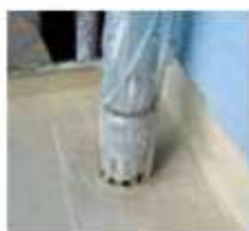
6 Detale zostały skutecznie uszczelnione.
