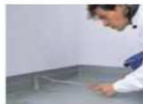
8 Położyć powłokę utrwalającą Triflex Cryl Finish 205 najpierw na detale, ...
