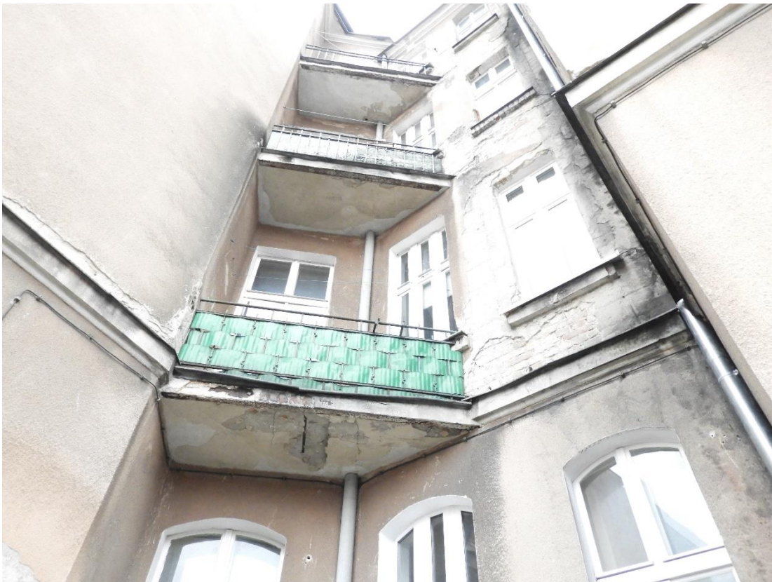
Fot. 7. Elewacja od strony podwórza, część z balkonami.
