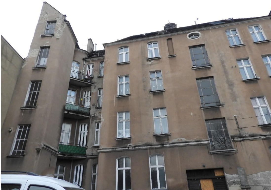
Fot. 5. Elewacja od strony podwórza.
