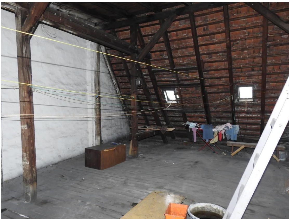
Fot. 10. Strych budynku przy ulicy Wierzbęćce 14 – nie odnaleziono śladów nietoperzy w tej części strychu.
