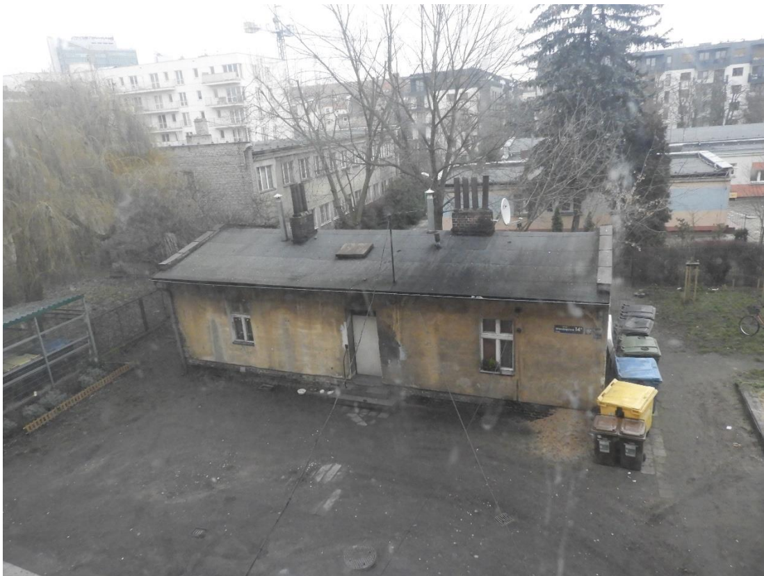
Fot. 16. Budynek Wierzbice 14b, widok z kamienicy.
