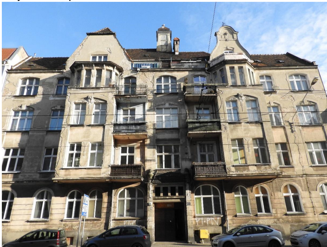
Fot. 2. Elewacja od strony ulicy Wierzbicice, bogato zdobiona elewacja.
