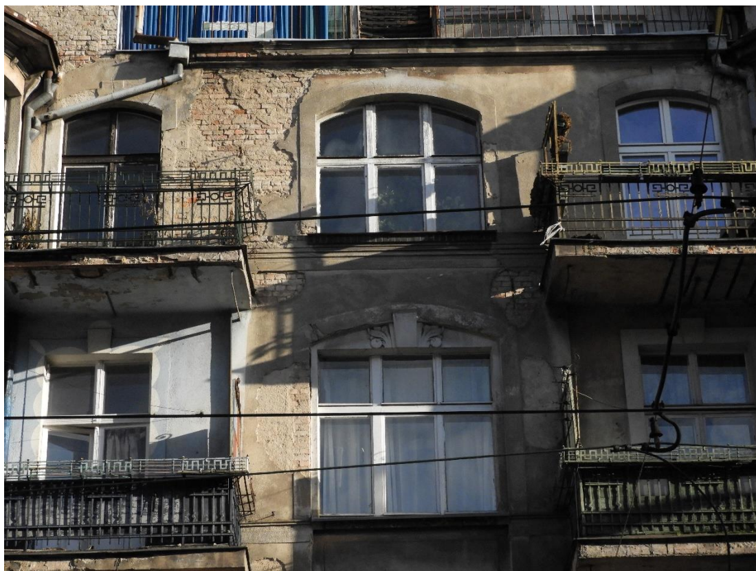
Fot. 3. Fragment elewacji frontowej.
