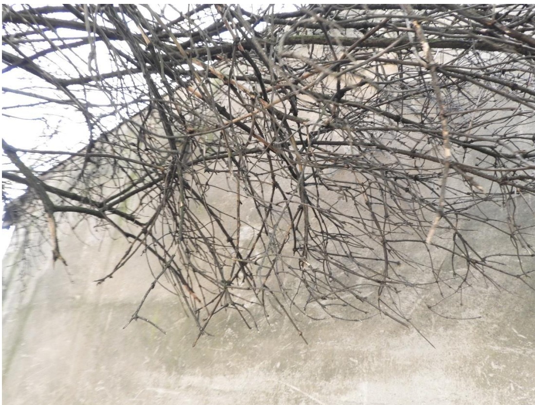
Fot. 18. Ściana szczytowa północna brak śladów gniazdowania ptaków.
