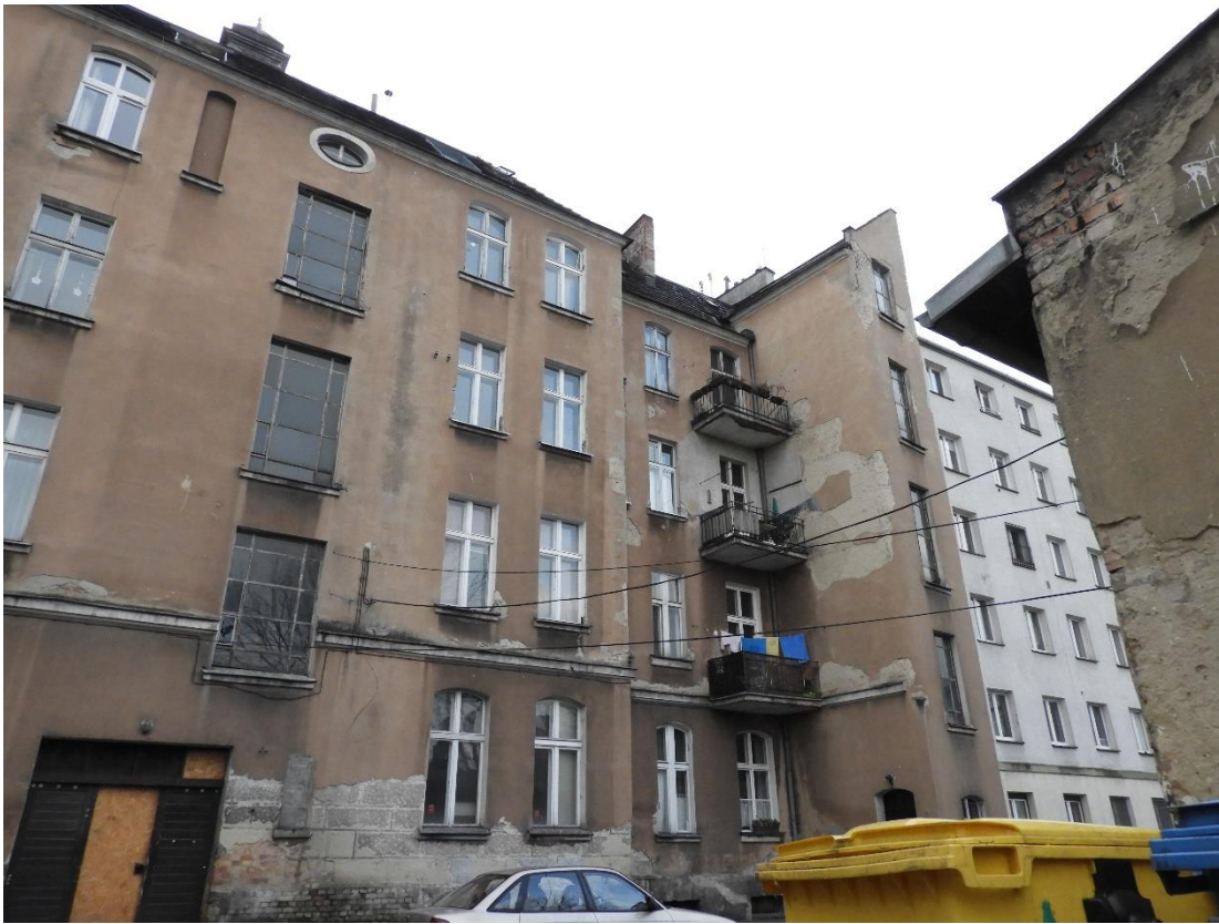
Fot. 6. Elewacja od strony podwórza.
