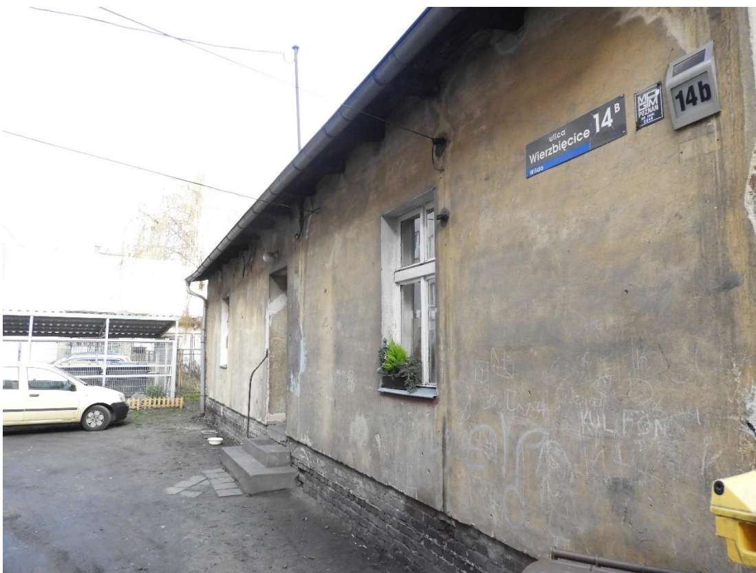
Fot. 17. Elewacja od strony podwórza, bark śladów gniazdowania ptaków.
