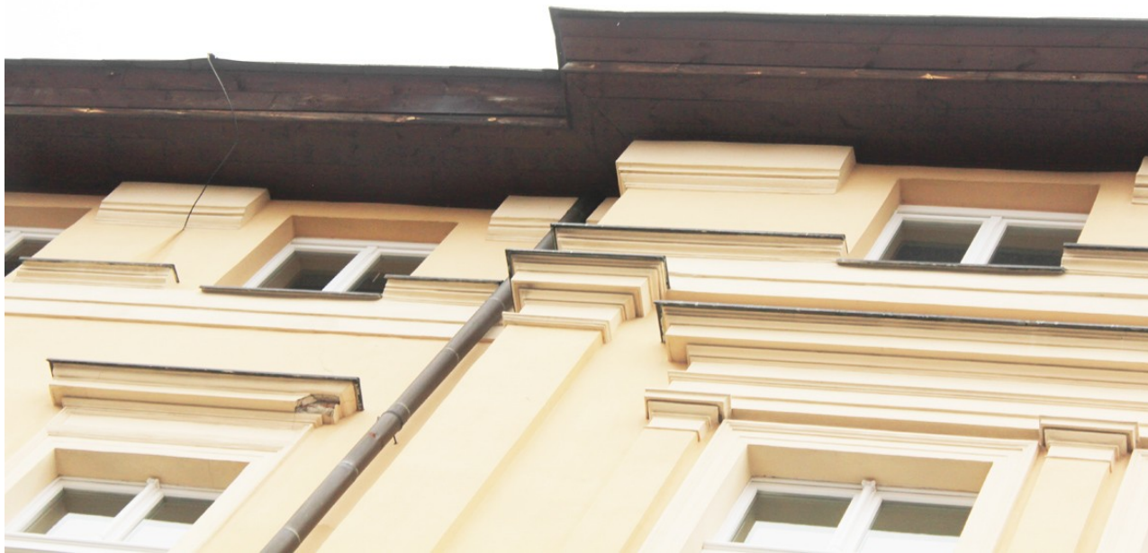
51. Budynek Biblioteki Pedagogicznej przy ul. Dąbrowskiego 4 w Toruniu. Jesień 2022 r. Stan zachowania (wtórnej) podbitki dachowej. (Fot. E. Płocińska)
