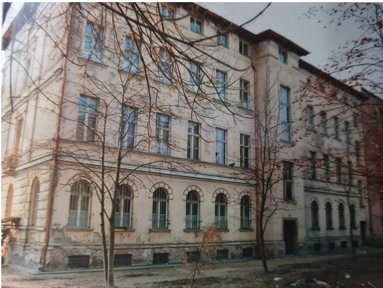
14. Budynek przy ul. Dąbrowskiego 4 w Toruniu. Elewacja tylna. Widok od strony wschodniej. Stan zachowania w 2003 r. (Źródło: Karta ewidencyjna...op. cit. )
