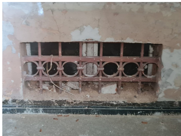
18. Budynek przy ul. Dąbrowskiego 4 w Toruniu. Elewacja frontowa, okienka doświetlające piwnicę. Stan zachowania w 2003 r. (Źródło: Karta ewidencyjna...op. cit. )
