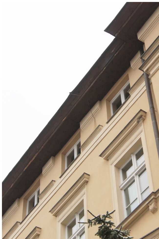
51. Budynek Biblioteki Pedagogicznej przy ul. Dąbrowskiego 4 w Toruniu. Jesień 2022 r. Stan zachowania (wtórnej) podbitki dachowej. (Fot. E. Płocińska)
