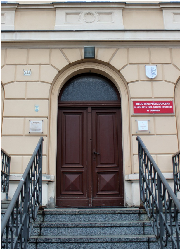
29. Budynek Biblioteki Pedagogicznej przy ul. Dąbrowskiego 4 w Toruniu. Stan zachowania na jesieni 2022 r. Wejście główne. (Fot. E. Płocińska)
