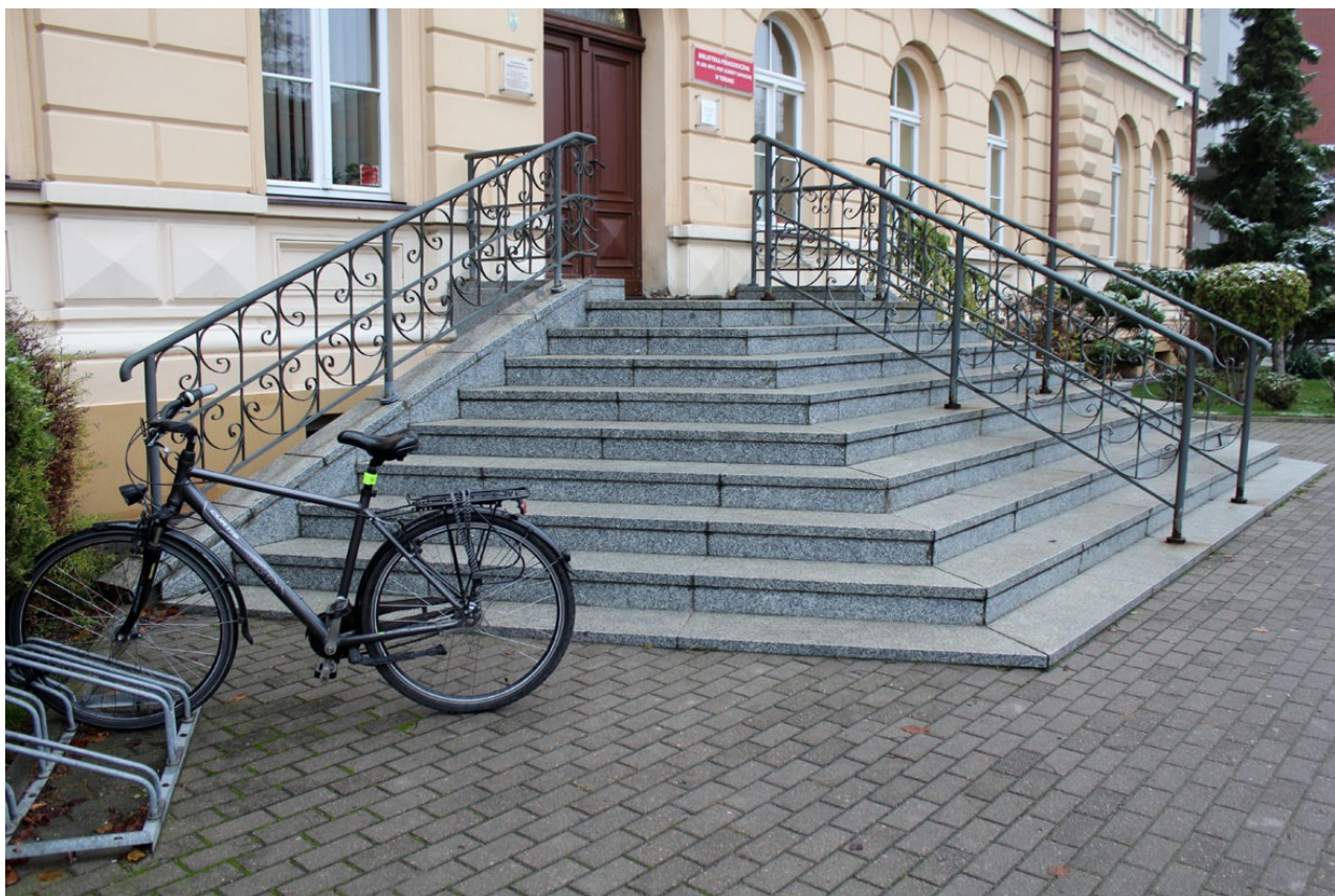
59. Budynek Biblioteki Pedagogicznej przy ul. Dąbrowskiego 4 w Toruniu. Jesień 2022 r. Współczesne schody prowadzące do wejścia głównego. (Fot. E. Płocińska)
