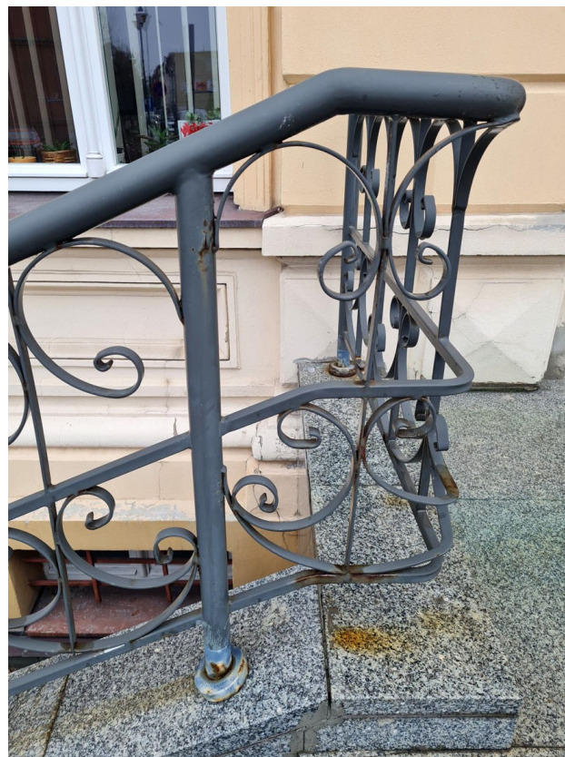
62. 63. Budynek Biblioteki Pedagogicznej przy ul. Dąbrowskiego 4 w Toruniu. Jesień 2022 r. Współczesne schody prowadzące do wejścia głównego. Ślady korozji na granitowej okładzinie. (Fot. E. Płocińska)
