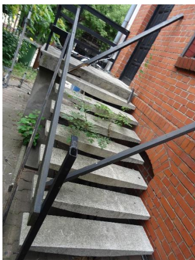
Fot. 12 Stopnie oraz barierka schodów przeznaczonych do demontażu
