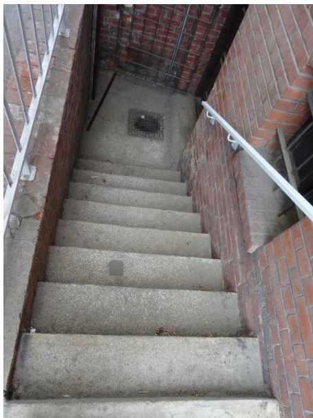
Fot. 10 Schody przy wejściu W1
