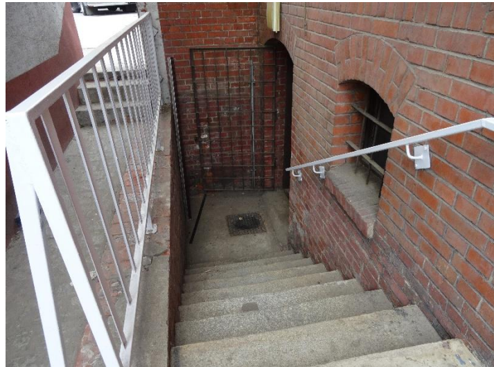
Zdj. 9. Pochwyt stalowy oraz barierka przy wejściu oznaczonym jako W1
