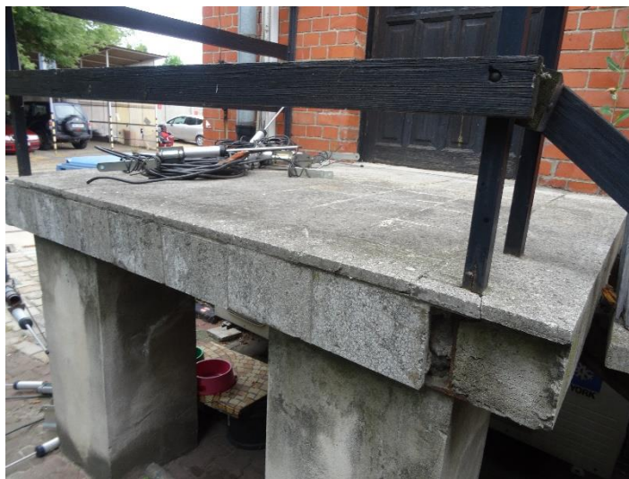
Fot. 13 Obudowa płyty spocznikowej oraz betonowe słupy.
