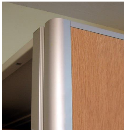
Rys. 4 - Ściana czołowa z panelem z płyty monoform.
