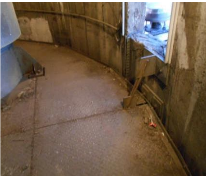
Fot. 30 - poziom 79,60m
