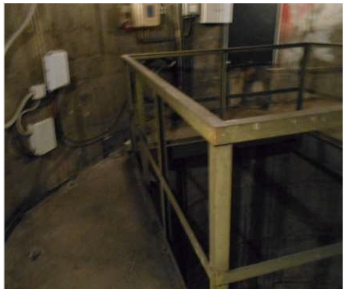
Fot. 25 - poziom 79,60m
