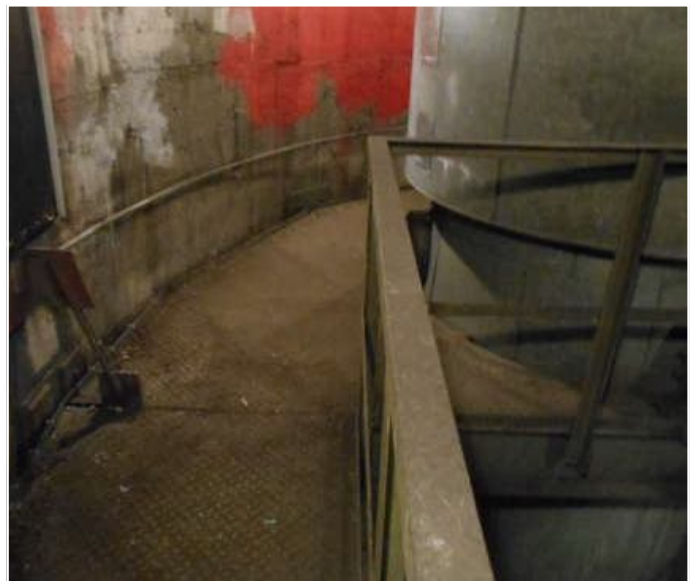
Fot. 23 - poziom 79,60m
