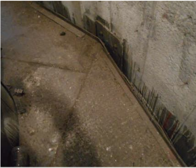
Fot. 32 - poziom 79,60m
