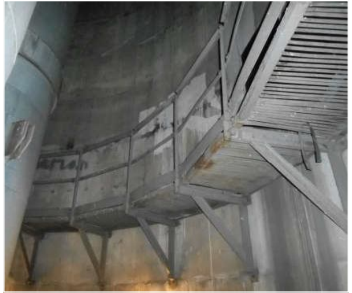
Fot. 3 - poziom 42,10m
