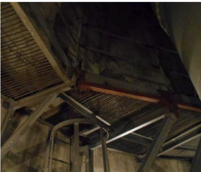
Fot. 6 - poziom 42,10m
