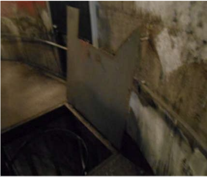
Fot. 26 - poziom 79,60m
