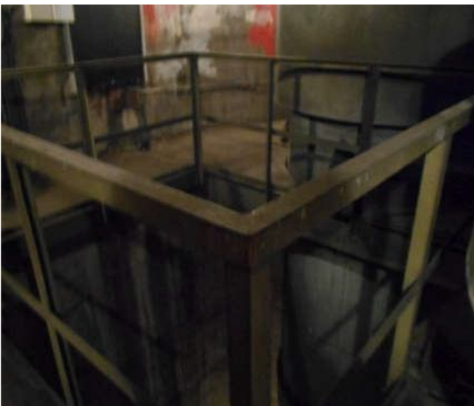
Fot. 24 - poziom 79,60m
