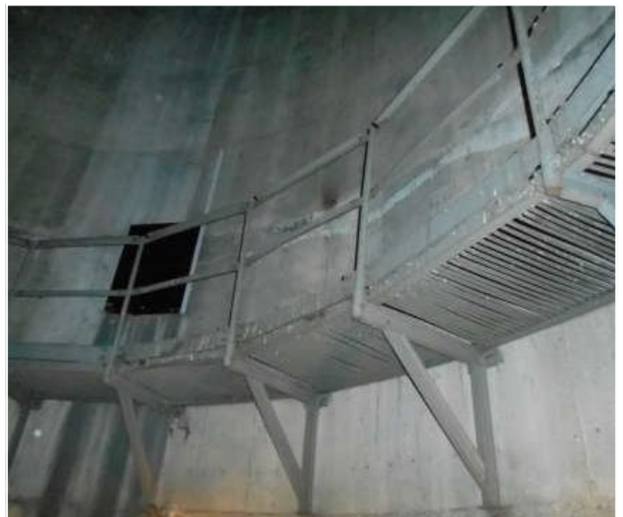
Fot. 13 - poziom 42,10m
