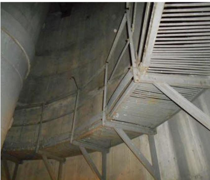
Fot. 4 - poziom 42,10m
