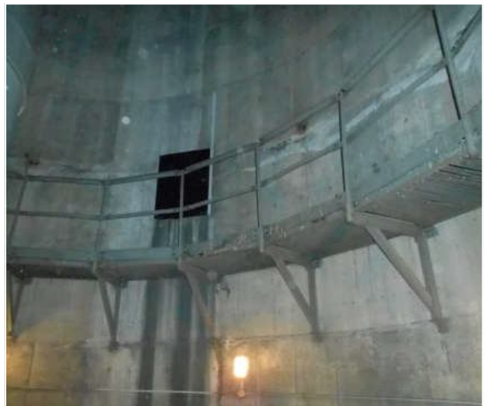
Fot. 7 - poziom 42,10m
