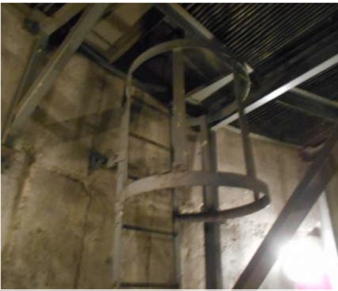
Fot. 20 - poziom 42,10m
