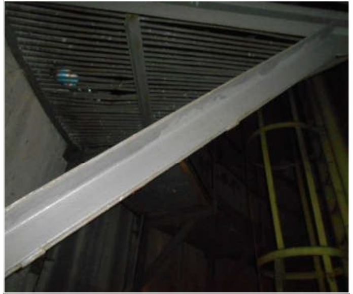
Fot. 15 - poziom 42,10m
