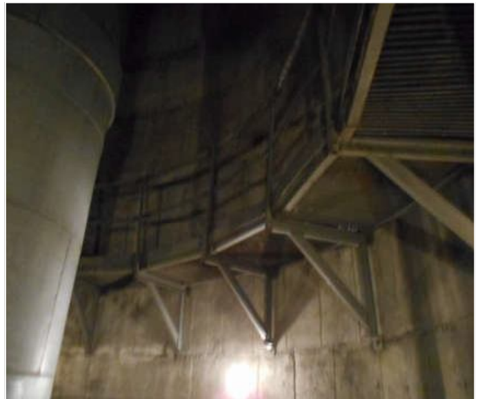
Fot. 17 - poziom 42,10m
