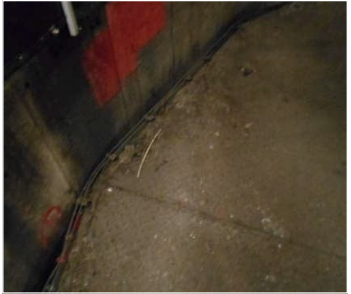
Fot. 33 - poziom 79,60m
