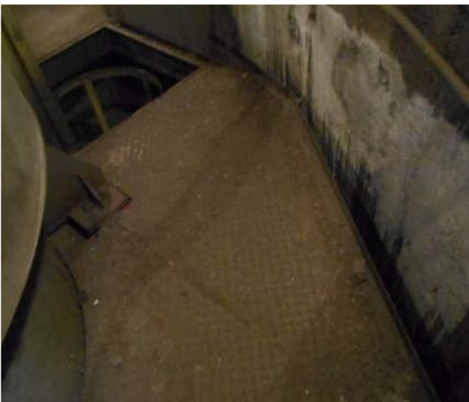
Fot. 28 - poziom 79,60m
