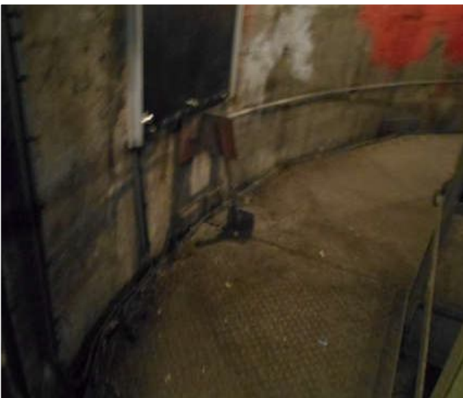
Fot. 22 - poziom 79,60m
