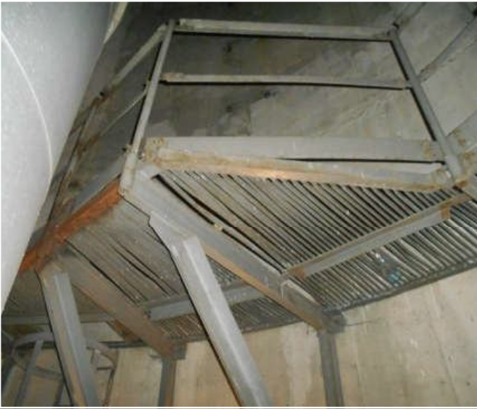
Fot. 2 - poziom 42,10m
