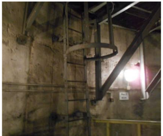
Fot. 19 - poziom 42,10m
