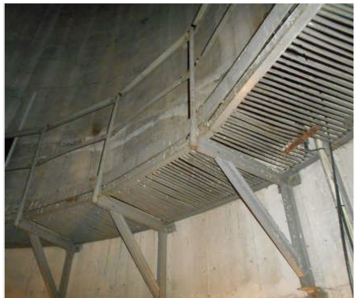
Fot. 5 - poziom 42,10m
