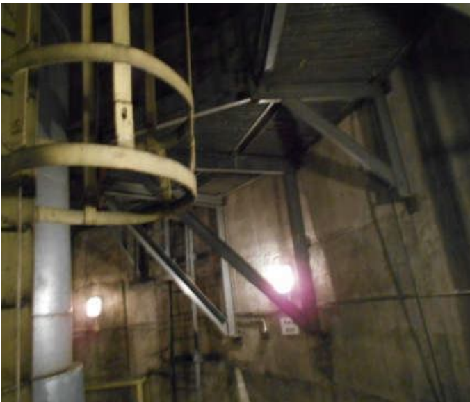
Fot. 16 - poziom 42,10m
