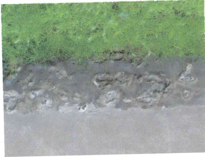
Fot. 11 Efekt podciągania wilgoci z gruntu
