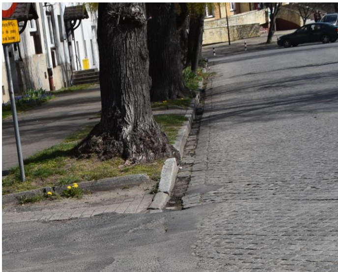
Zdj. 5-6. Uszkodzenia krawężników i jezdni przez korzenie drzew.
