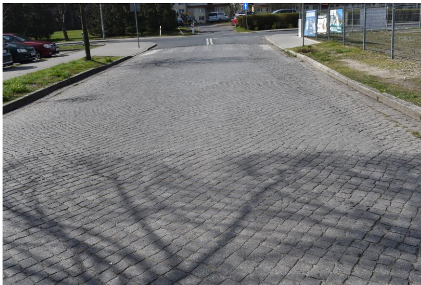
Zdj. 1. Nawierzchnia ul. Mieszka I – początek opracowania.
