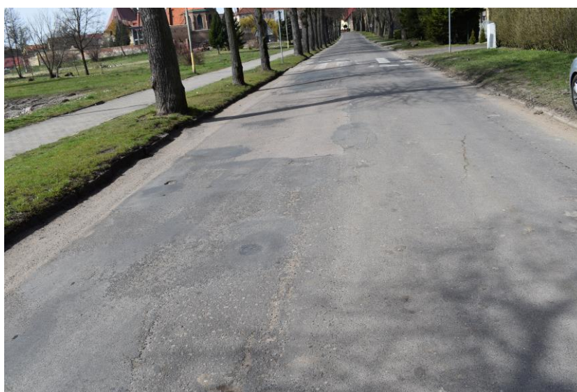
Zdj. 4. Nawierzchnia ul. Dworcowej – koniec opracowania.
