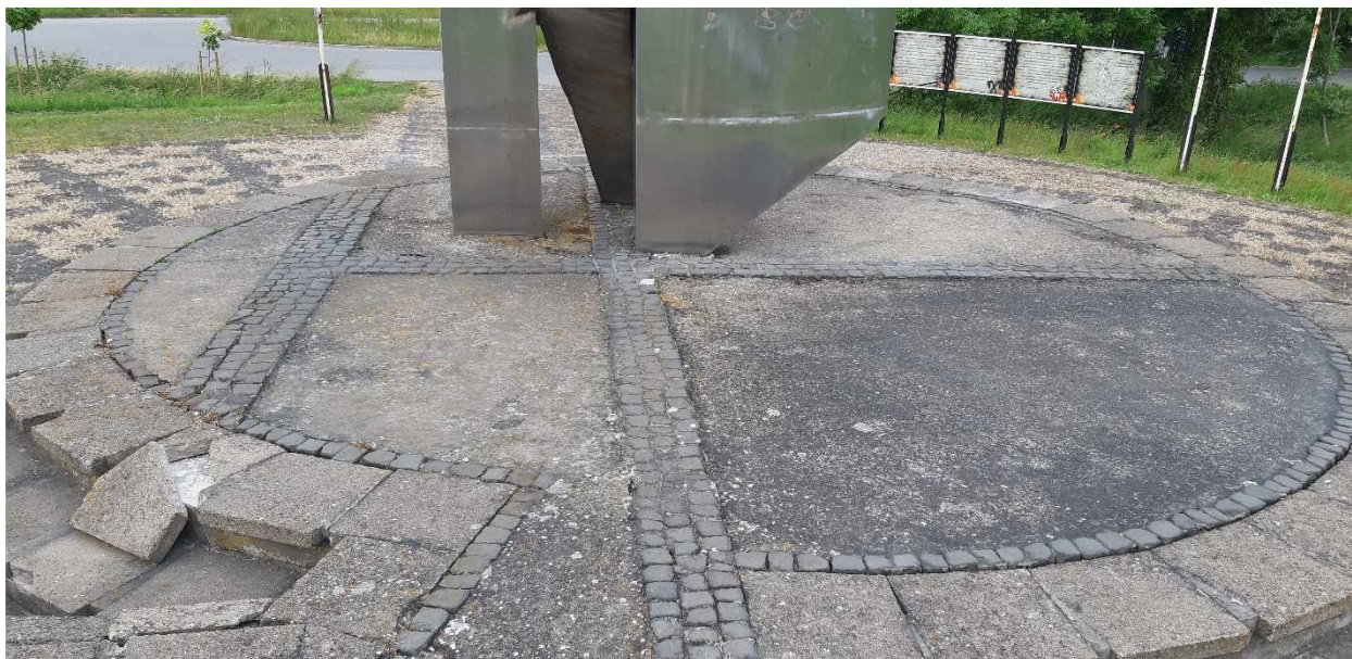
Fot.19. Podest – widok zdobienia z kostki kamiennej i uszkodzonych stopni schodowych źródło: opracowanie własne
