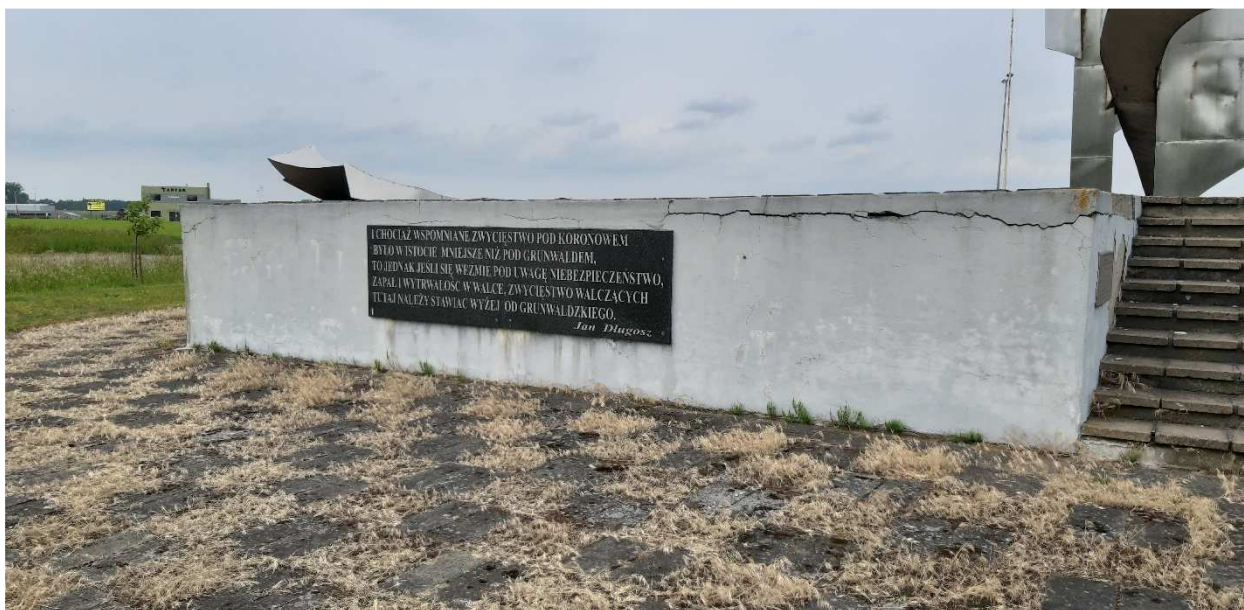
Fot.23. Ściana podestu od strony zachodniej – widok oddylatowania się płyty od ściany źródło: opracowanie własne
