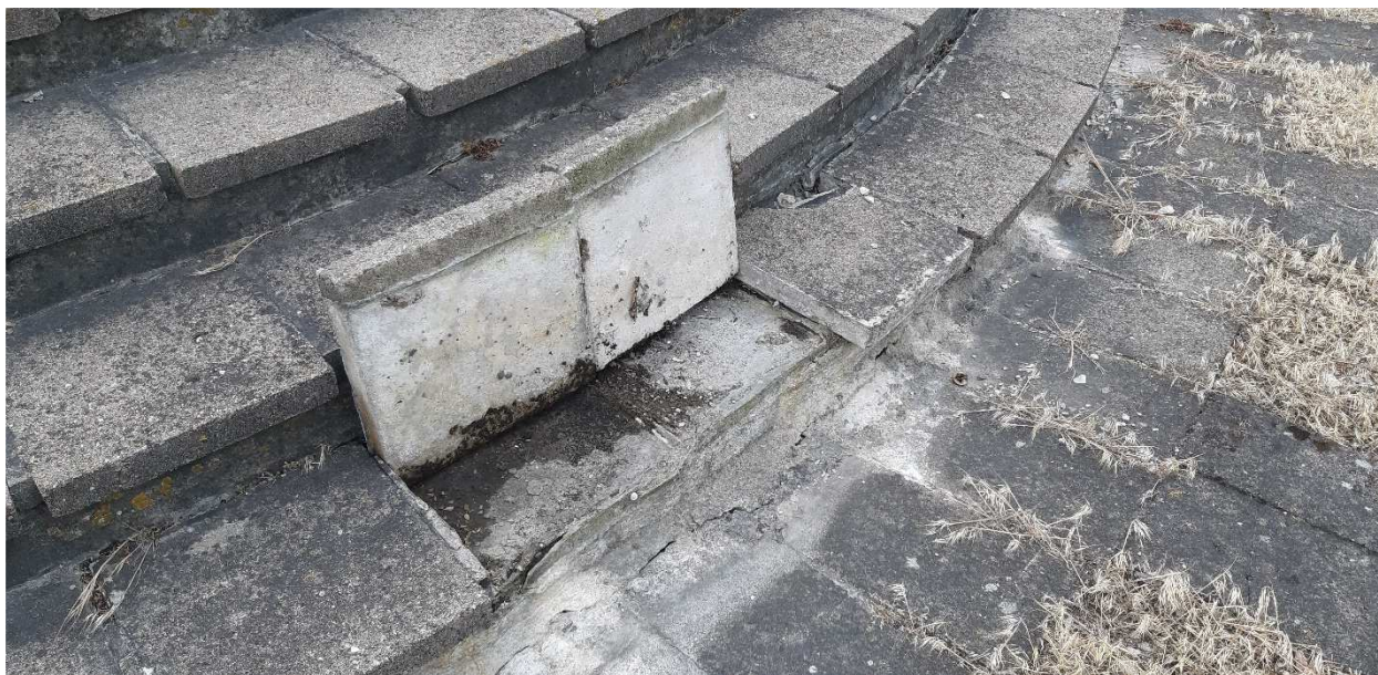
Fot.20. Widok luźnych stopni schodowych źródło: opracowanie własne
