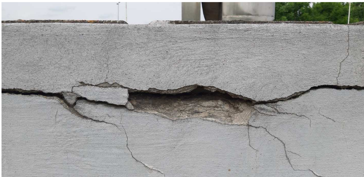
Fot.26. Ściana podestu od strony północnej – rysa pozioma źródło: opracowanie własne
