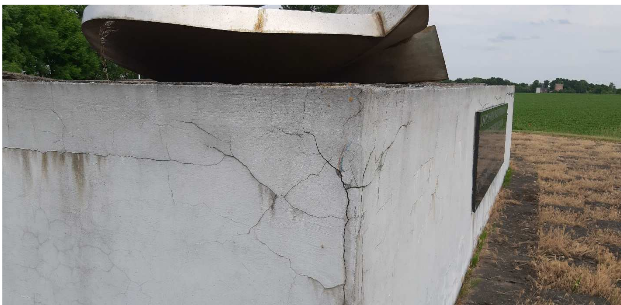
Fot.25. Zarysowanie ściany postumentu źródło: opracowanie własne
