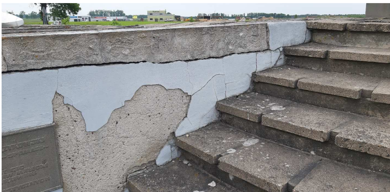
Fot.27. Ściana podestu od strony południowej – luźny, odpadający tynk źródło: opracowanie własne
