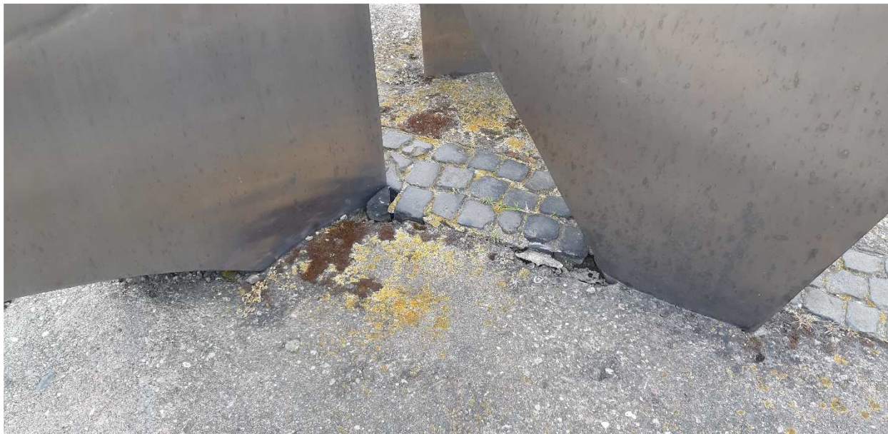
Fot.10. Miejsce posadowienia mieczy w podeście betonowym źródło: opracowanie własne
