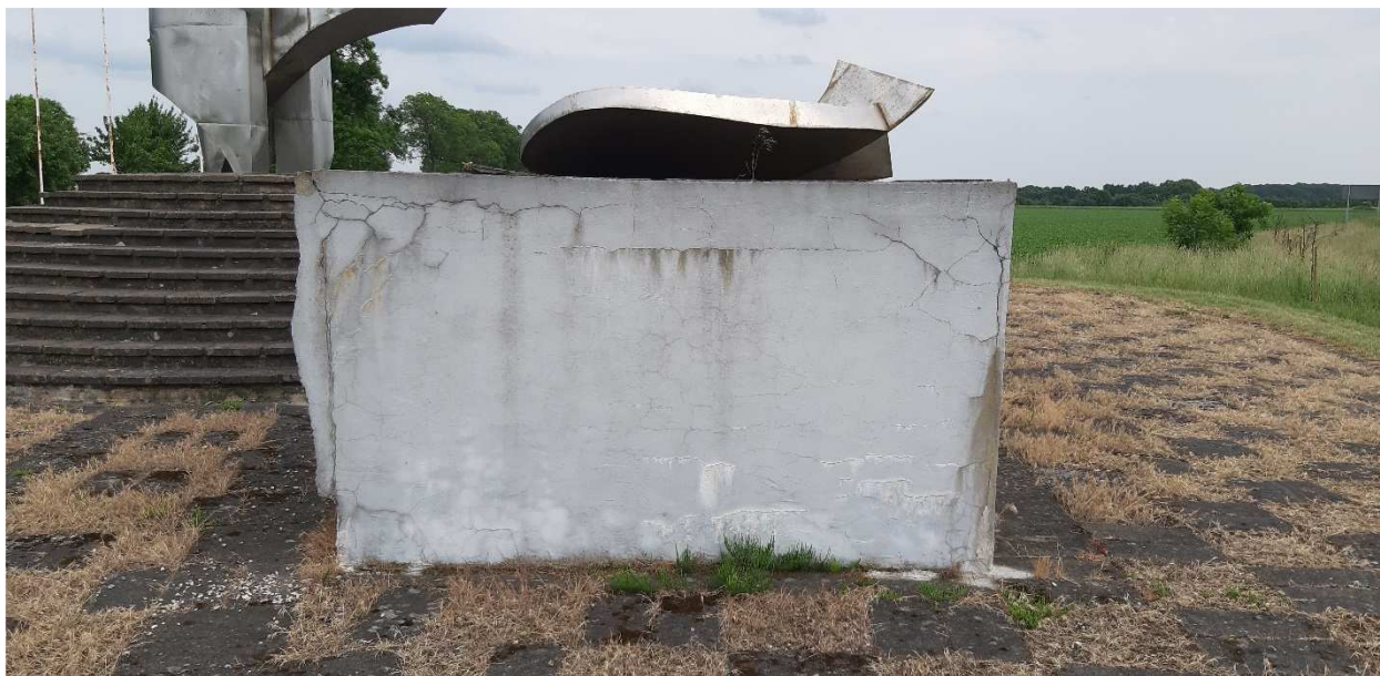
Fot.24. Ściana podestu od strony północnej – widok oddylatowania się płyty od ściany źródło: opracowanie własne
