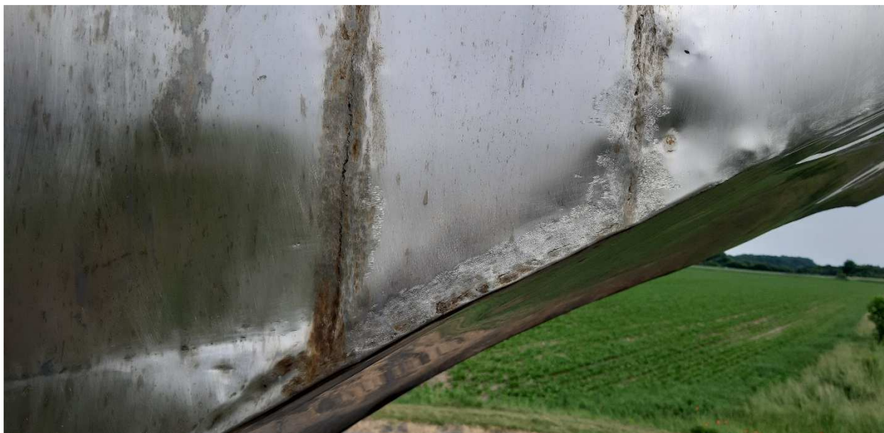
Fot.8. Stan techniczny i korozja spoin spawalniczych źródło: opracowanie własne
