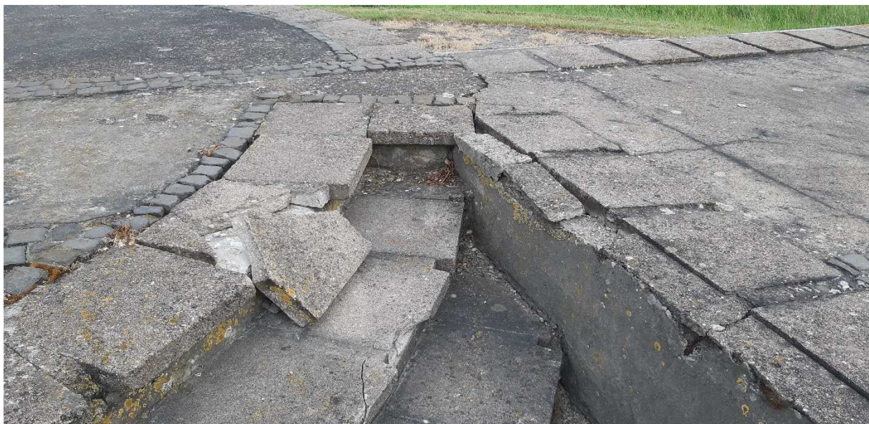
Fot.22. Widok luźnych i uszkodzonych stopni schodowych źródło: opracowanie własne
