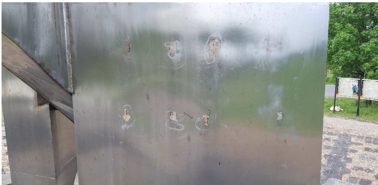
Fot.11. Ślady po spawach punktowych, widoczny sposób oszlifowania i polerowania miejsca spawu. źródło: opracowanie własne
