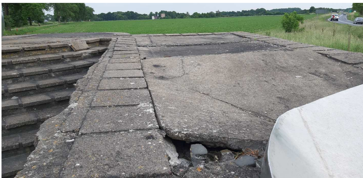
Fot.31. Płyta górna postumentu – zapadnięte elementy płyty źródło: opracowanie własne
