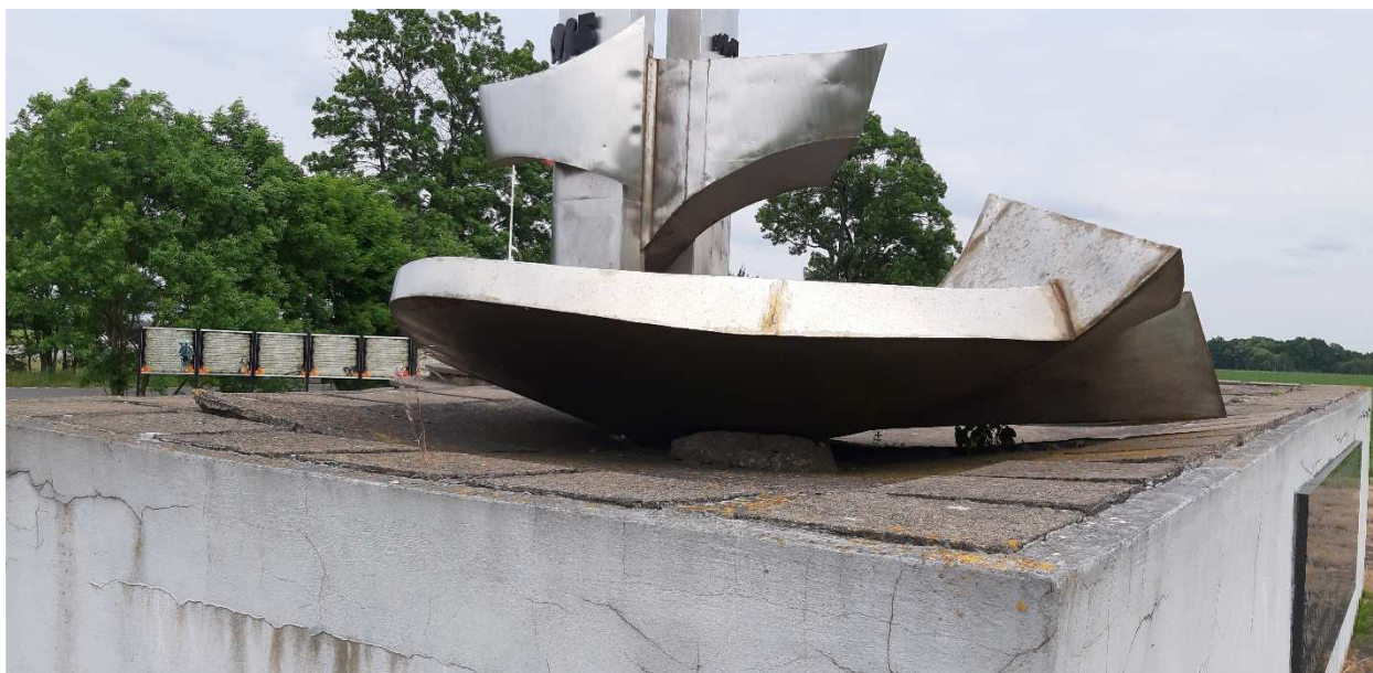
Fot.16. Niecka ze stali nierdzewnej – sposób mocowania do podestu źródło: opracowanie własne
