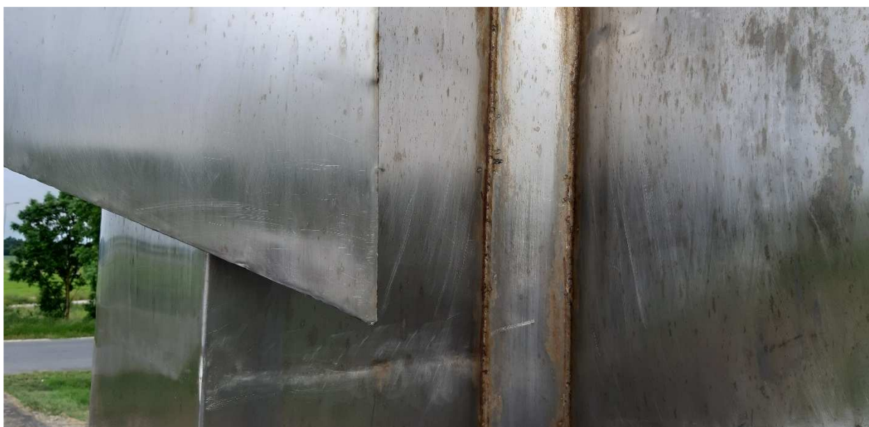
Fot.9. Stan techniczny i korozja spoin spawalniczych źródło: opracowanie własne
