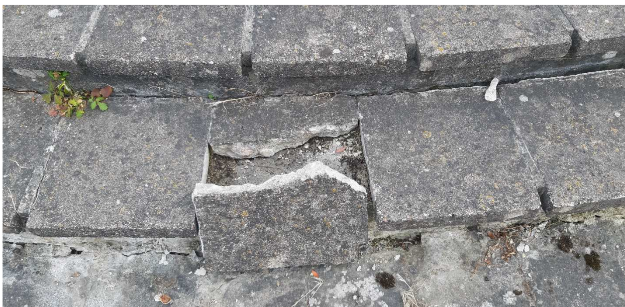
Fot.21. Widok uszkodzonych stopni schodowych źródło: opracowanie własne
