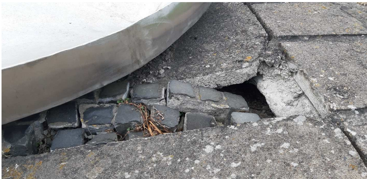
Fot.30. Płyta górna postumentu – zapadnięte elementy płyty źródło: opracowanie własne
