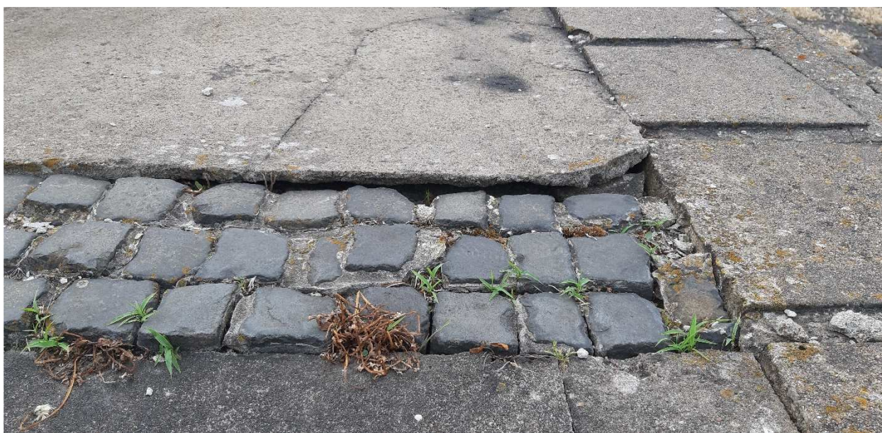
Fot.29. Płyta górna postumentu – pęknięcia i osiadanie elementów płyty źródło: opracowanie własne
