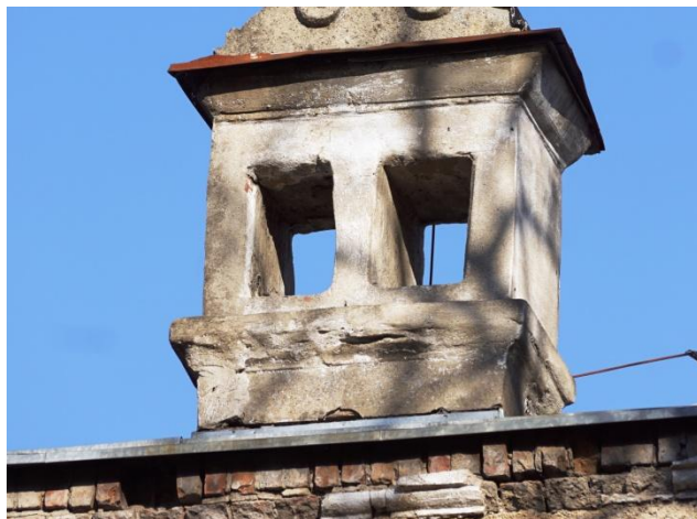
Fot. nr 18, 19. Widoczne ubytki i odpajanie się od podłoża detalu architektonicznego. Na fot. 19 widać całkowity ubytek profilowanego w technice ciągniętej gzymsu.
