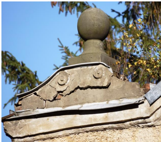
Fot. nr 18, 19. Widoczne ubytki i odpajanie się od podłoża detalu architektonicznego. Na fot. 19 widać całkowity ubytek profilowanego w technice ciągniętej gzymsu.
