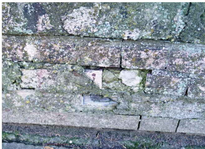
Fot. nr 14, 15. Widoczne ubytki oraz odspajanie się tynków na powierzchni słupa oraz cokołu.
