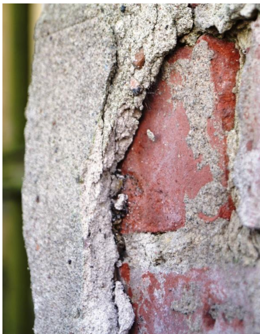
Fot. nr 14, 15. Widoczne ubytki oraz odspajanie się tynków na powierzchni słupa oraz cokołu.
