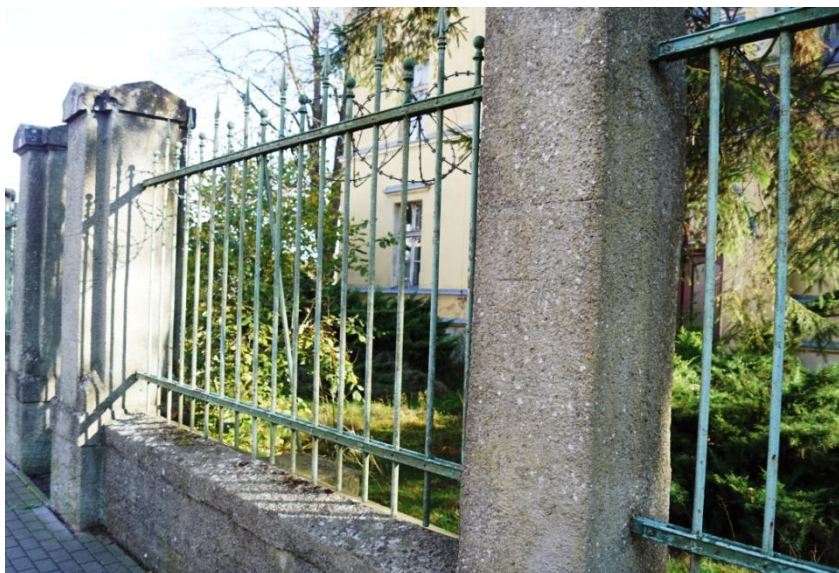
Fot. nr 4. Fragment ogrodzenia od strony ulicy Zagórskiej ze stalowymi pręslami.
