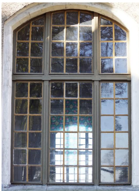
Fot. nr 22. Okno wschodniej elewacji.
