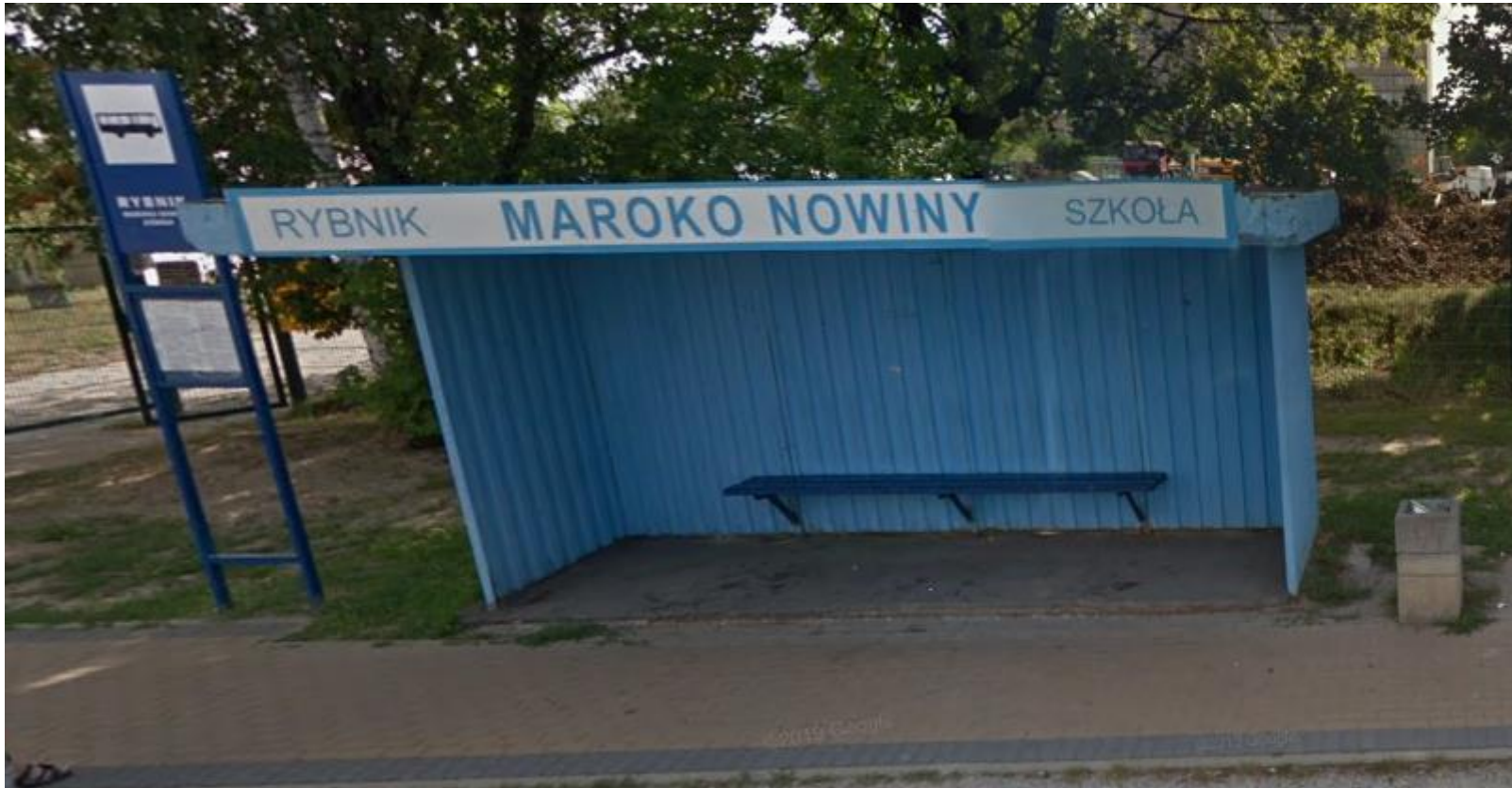
Rys. 14.1. Widok miejsca na wiatę przystankową.
