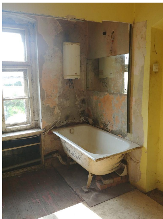
Zdjęcie 36 Wejście do pustostanu na piętrze, w skrzydle południowym. Widoczny zaciec na suficie oraz tynki ścian w złej kondycji.
