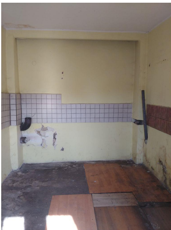
Zdjęcie 36 Wejście do pustostanu na piętrze, w skrzydle południowym. Widoczny zaciec na suficie oraz tynki ścian w złej kondycji.
