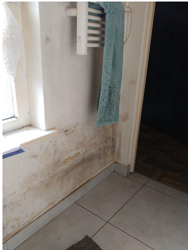
Zdjęcie 27, 28 Mieszkanie na parterze po prawej stronie. Pleśń na ścianie w przedpokoju i w łazience
