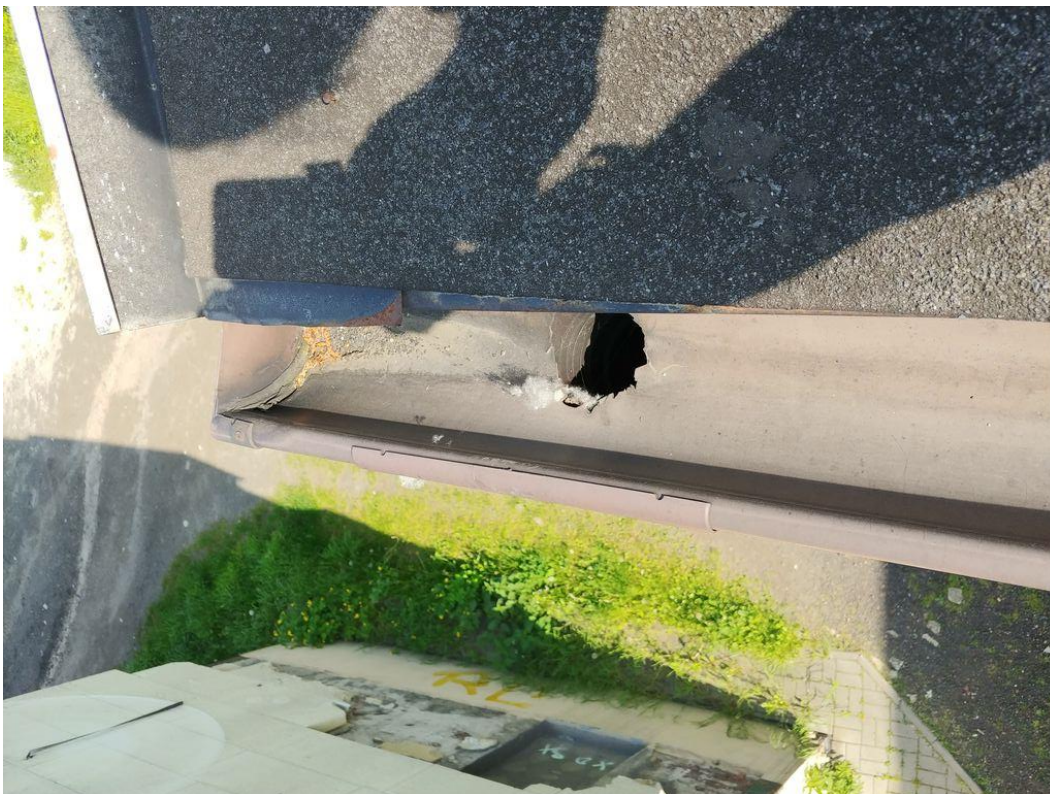
Zdjęcie 6 sposób wykonania otworu w rynnie w miejscu połączenia z rurą spustową.
