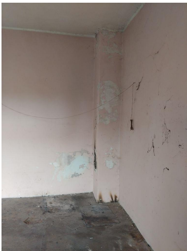
Zdjęcie 42 Ślady po ogniu na kominie pochodzą z pustostanu z osobnym wejściem!
