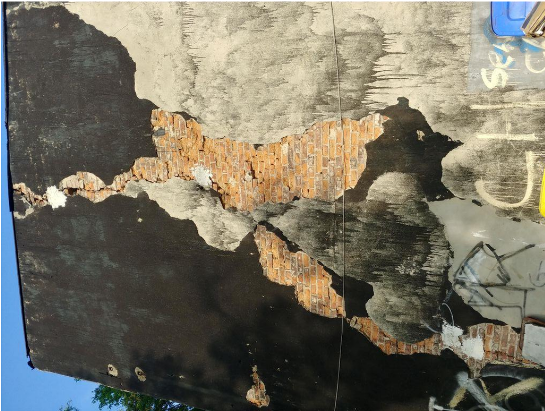
Zdjęcie 19, 20 Zachodnia ściana szczytowa. Pomimo, że założone plomby nie są uszkodzone, to ściana wymaga niezwłocznej naprawy.
