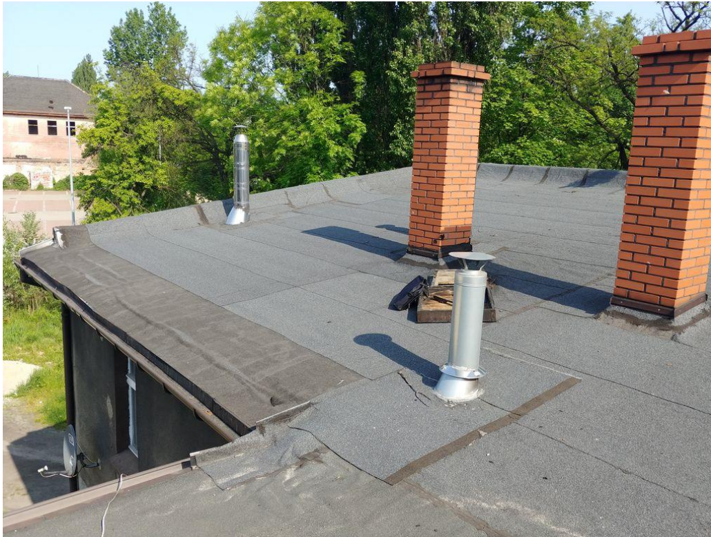
Zdjęcie 2 Dach nad północną częścią budynku – widok ogólny
