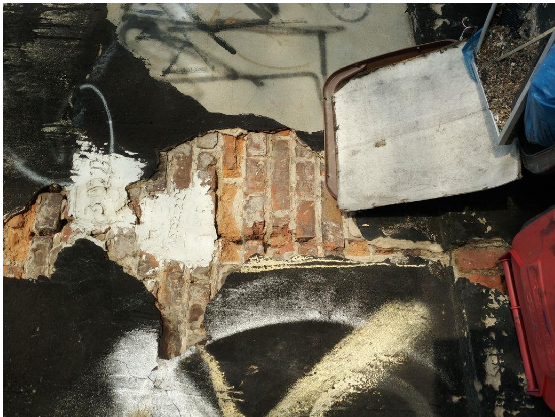
Zdjęcie 19, 20 Zachodnia ściana szczytowa. Pomimo, że założone plomby nie są uszkodzone, to ściana wymaga niezwłocznej naprawy.
