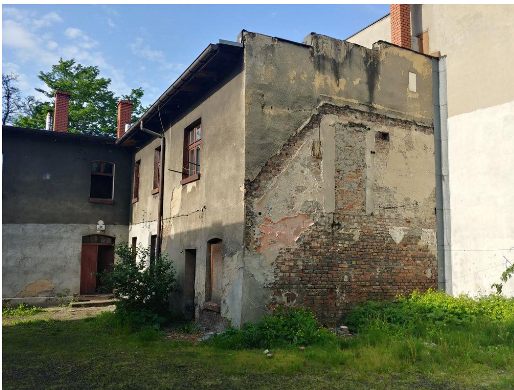
Zdjęcie 16 Skrzydło południowe budynku i ściana szczytowa. Widok ogólny.
