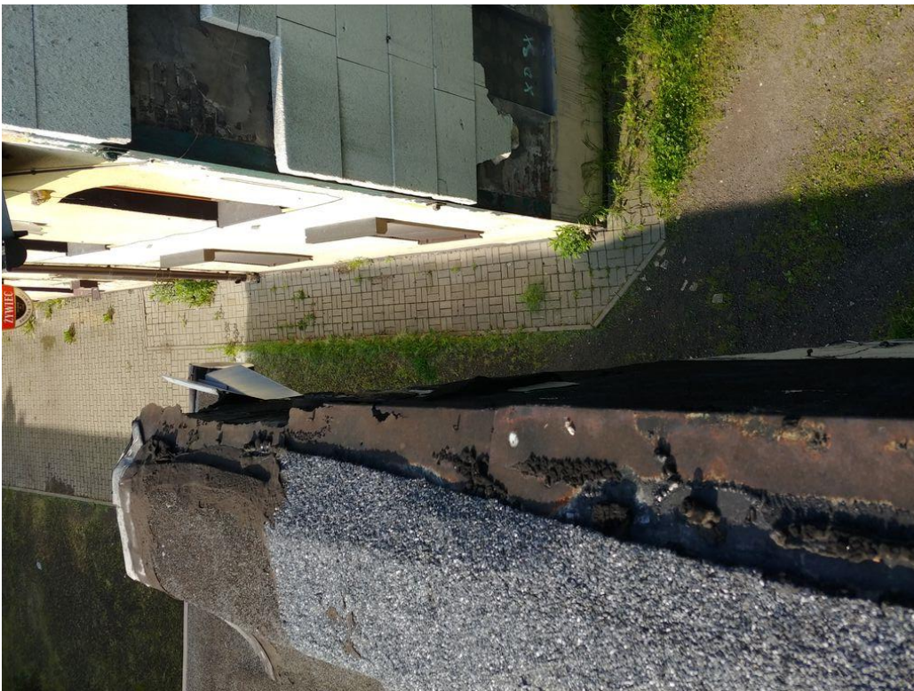
Zdjęcie 8. Ogniomur na ścianie zachodniej
