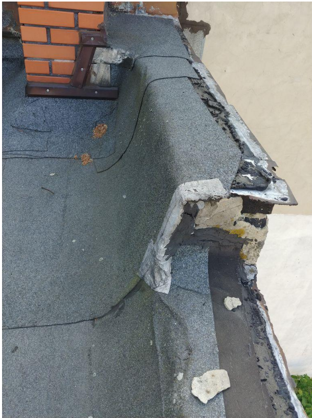
Zdjęcie 10, 11 Ogniomur. Strona południowa. Wykonanie to nie zapewnia szczelności pokrycia dachowego.
