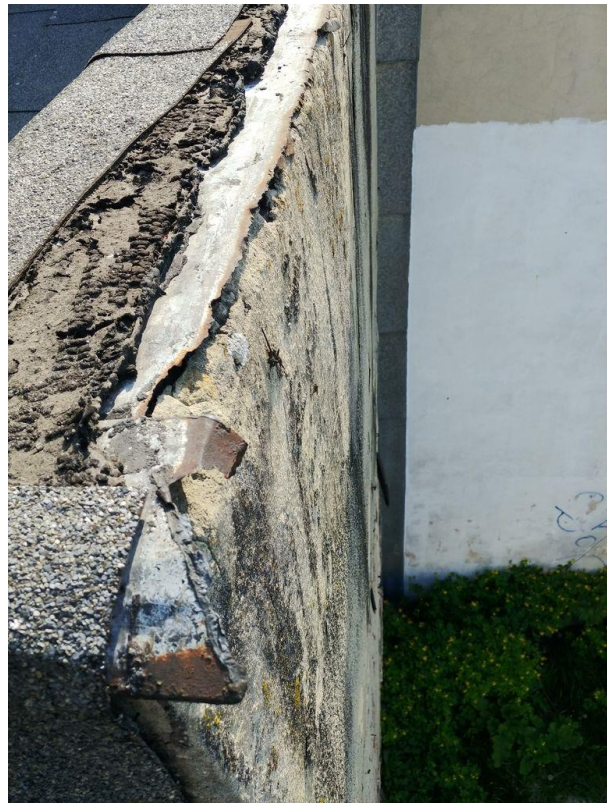
Zdjęcie 10, 11 Ogniomur. Strona południowa. Wykonanie to nie zapewnia szczelności pokrycia dachowego.
