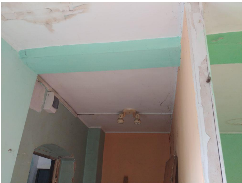
Zdjęcie 36 Wejście do pustostanu na piętrze, w skrzydle południowym. Widoczny zaciec na suficie oraz tynki ścian w złej kondycji.
