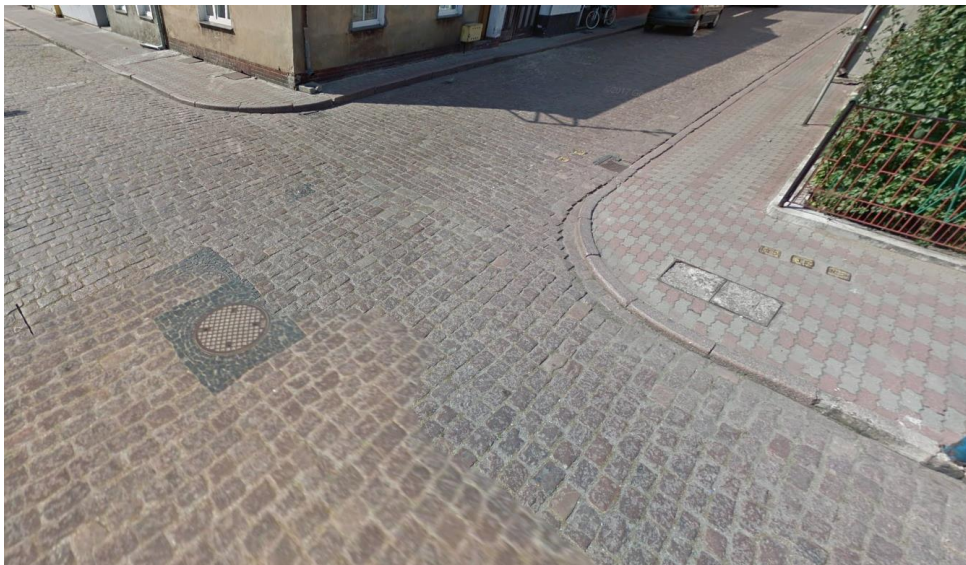
Zdj. 1 – Ist. nawierzchnia jezdni ul. Sienkiewicza – studnie KS.
