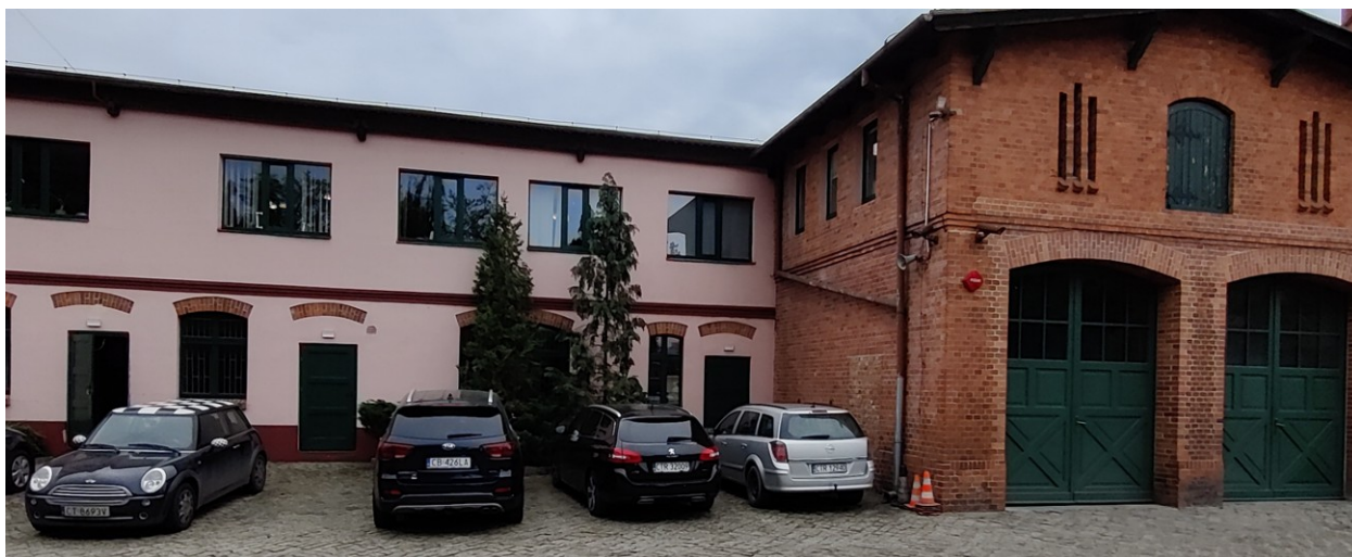
Zdjęcie nr 3.20 Zdjęcie elewacji wewnętrznej – połączenie budynku „A” z budynkiem „B” – przewidzianym do rozbiórki.
