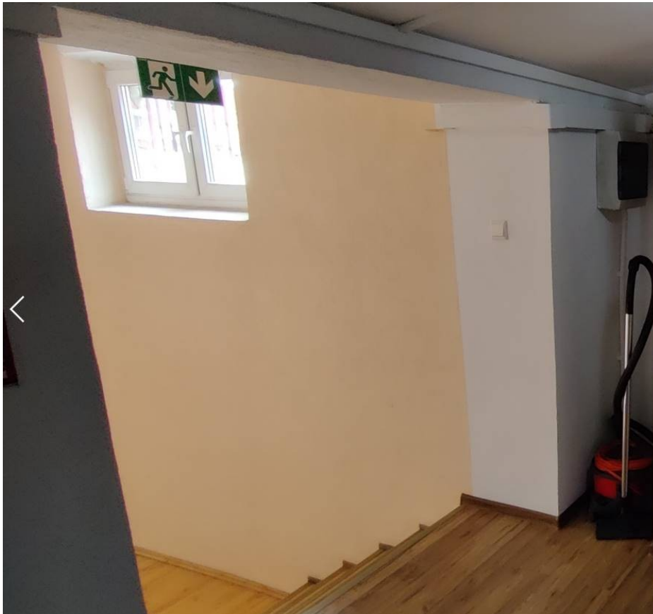
Zdjęcie nr 3.22 Zdjęcie poziomu I piętra – przejście między budynkiem „B” przeznaczonym do rozbiórki (schody, część obniżona) a budynkiem „A” przeznaczonym do pozostawienia (ściany i część wyższa).
