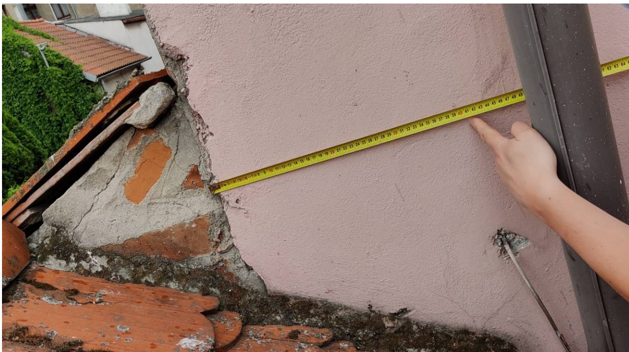
Zdjęcie nr 3.17. Zdjęcie oparcia ściany zewnętrznej – prostopadłej na ścianie muru zabytkowego - ok. 41cm
