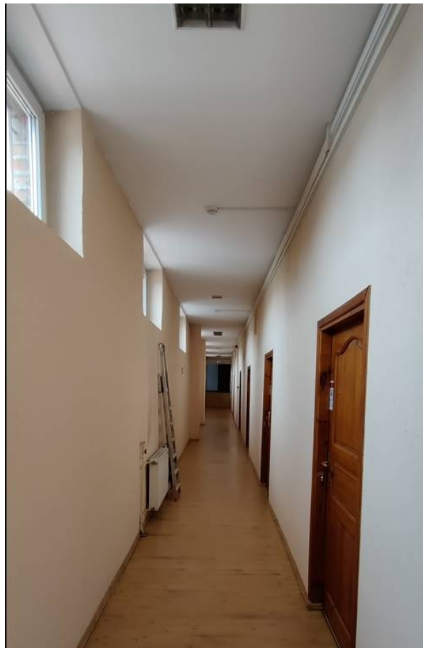
Zdjęcie nr 3.15. Zdjęcie ściany od wewnątrz –I piętro – brak zarysowań/zawilgoceń
