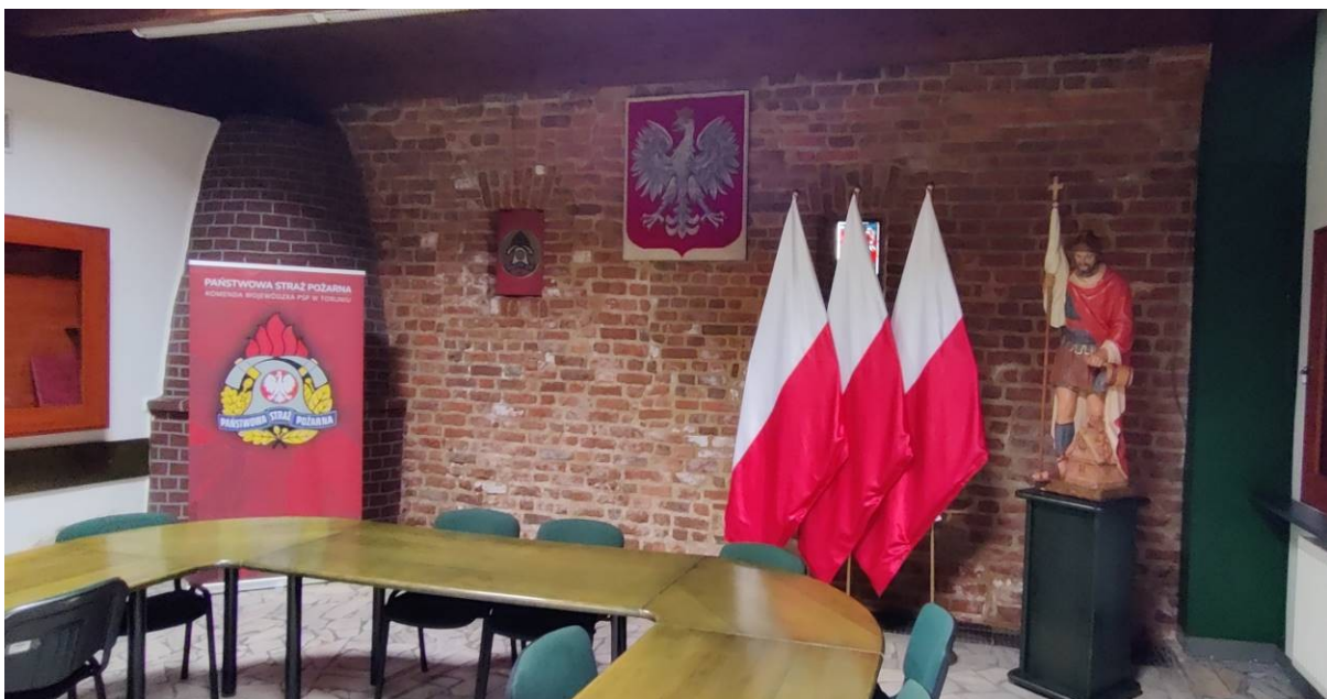
Zdjęcie nr 3.9. Zdjęcie ściany od wewnątrz – istniejący mur obronny oraz nadbudowa ( uzupełnienia nową cegłą ) – zasłonięta częściowo belką nośną dachu.
