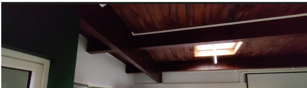
Zdjęcie nr 3.5. Zdjęcie ściany od wewnątrz – istniejący mur oporowy fosy oraz nadbudowa – zasłonięta belką nośną dachu – oparcie wymian drewnianego na ścianie – murze istniejącym.
