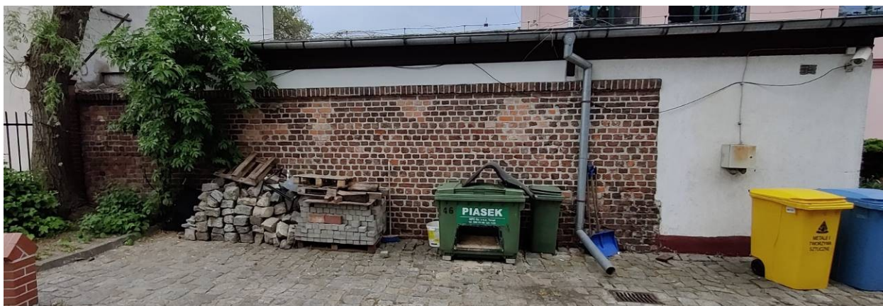
Zdjęcie nr 3.1. Zdjęcie elewacji zewnętrznej – istniejący mur oporowy fosy oraz dobudowa i nadbudowa (tynkowana).
