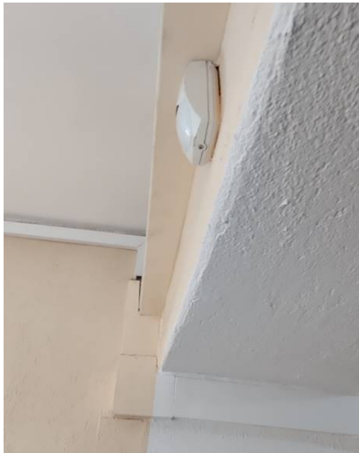
Zdjęcie nr 3.23 Zdjęcie poziomu I piętra – przejście między budynkiem „B” przeznaczonym do rozbiórki (część wyższa stropu) a budynkiem „A” przeznaczonym do pozostawienia – stara ściana, otynkowana.
