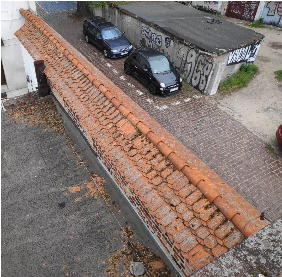
Zdjęcie nr 3.8. Zdjęcie muru obronnego od góry z nadbudową – nowa cegła oraz dachówka karpiówka – papa wywinięta na ścianę muru.
