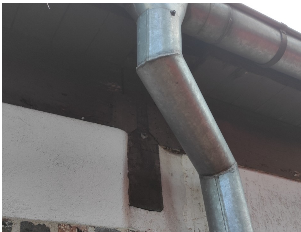
Zdjęcie nr 3.4. Zdjęcie ściany od zewnątrz – oparcie belki głównej 50cm z drewna klejonego typu „Cierpickiego”
