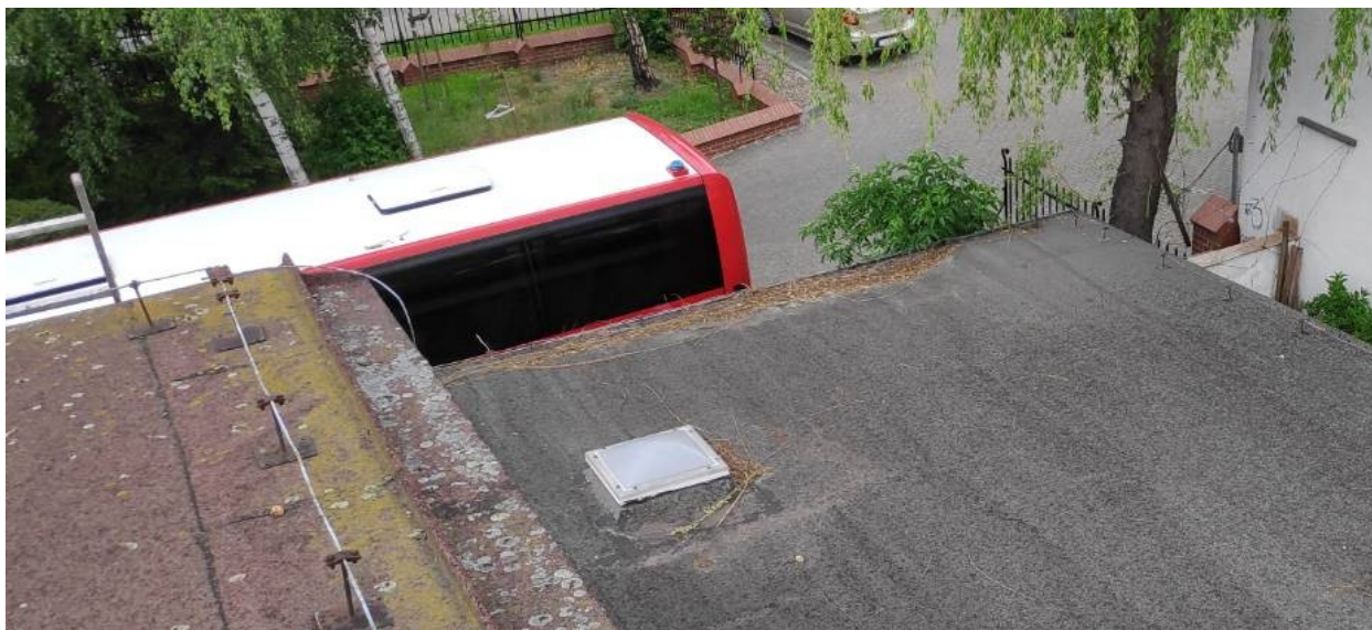
Zdjęcie nr 3.6. Zdjęcie dachu od góry – oparcie przekrycia – papa na ścianie muru.
