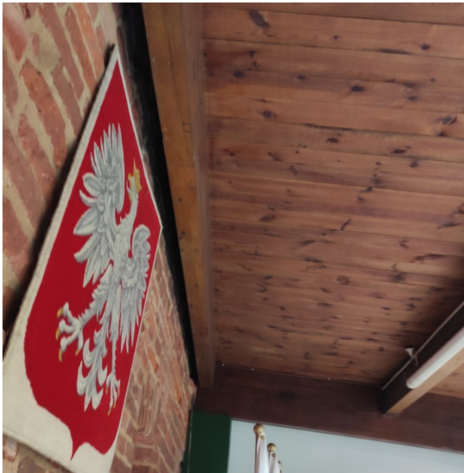
Zdjęcie nr 3.10. Zdjęcie belki skrajnej dachu przy konstrukcji muru
