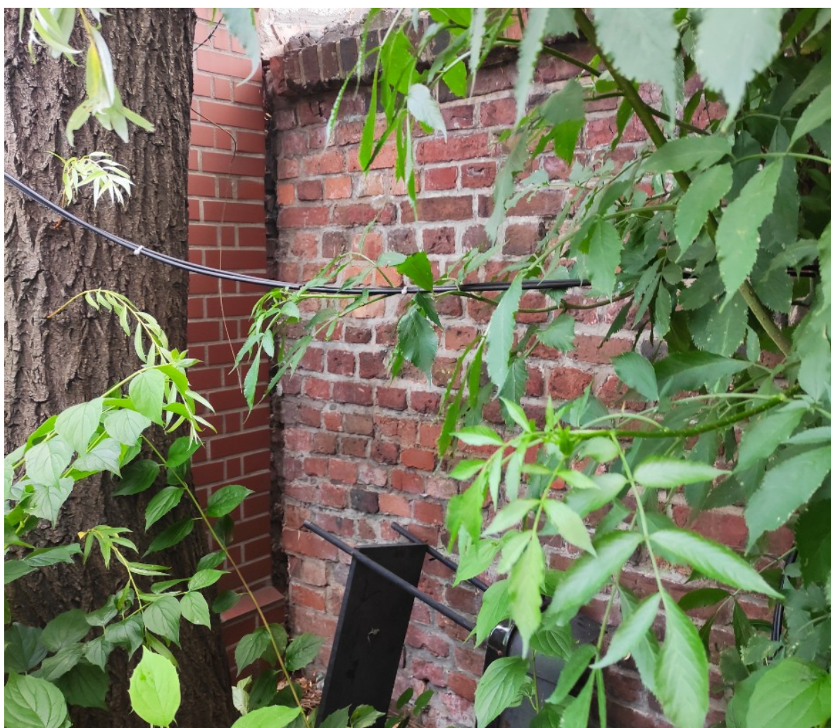
Zdjęcie nr 3.2. Zdjęcie elewacji zewnętrznej – istniejący mur oporowy fosy dostawiony do budynku sąsiedniego ( konstrukcje rozdzielne ).
