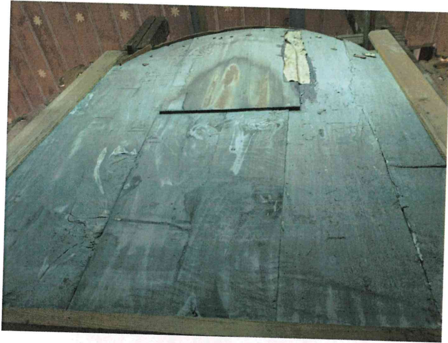
Fot. 12. Zabrudzenia tyłu ołtarza.
