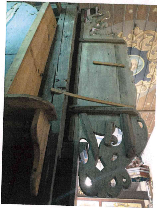
Fot. 13. Wtórne listwy zabezpieczające konstrukcję.
