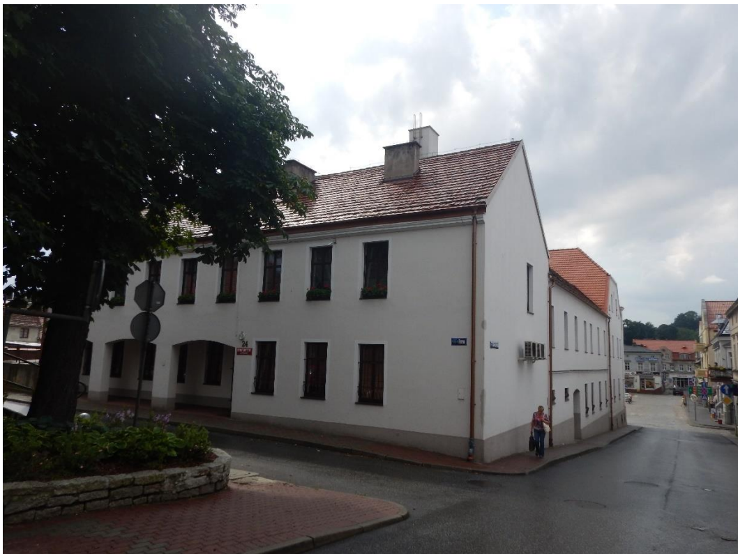
Fot.1 Elewacja budynku od ul. Garncarskiej
