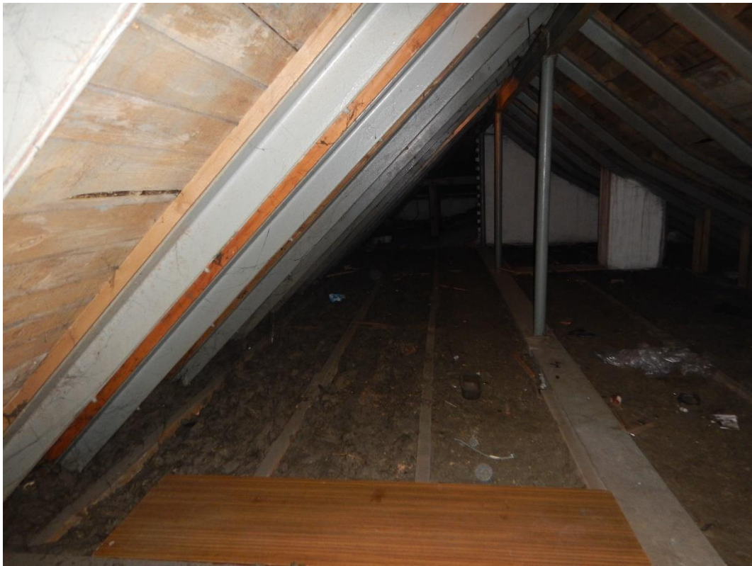
Fot.31 Dach tęcznika - konstrukcja stalowa
