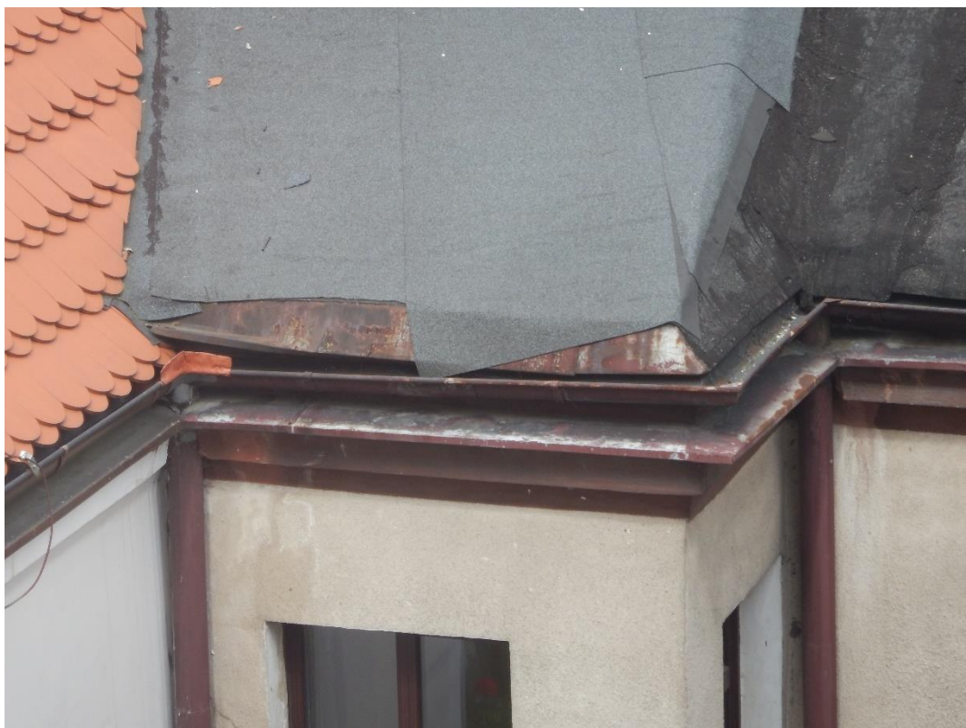
Fot.12 Dach łącznika - orynnowanie przy budynku Ratusza
