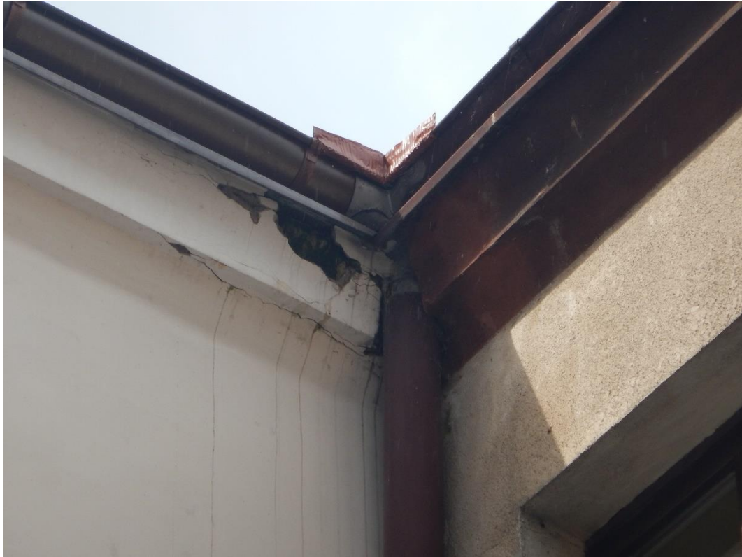
Fot.13 Gzyms i narożnik rynny na połączeniu dachu łącznika z dachem Ratusza
