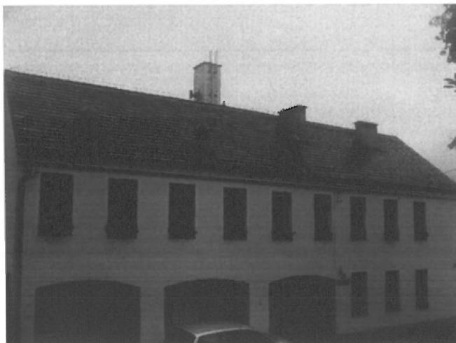
Dach od strony Farnej 24.
