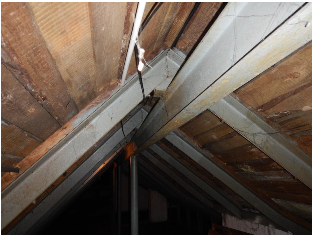
Fot.32 Dach tęcznika - konstrukcja stalowa
