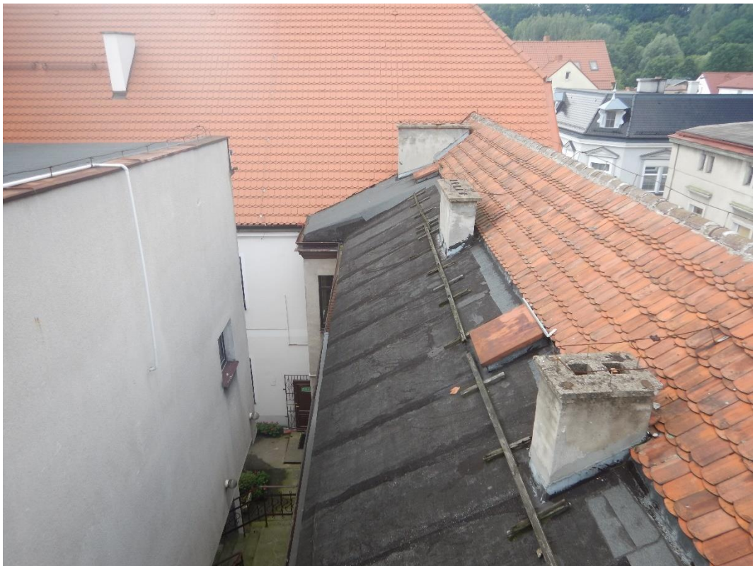
Fot.4 Dach łącznika - potać południowa
