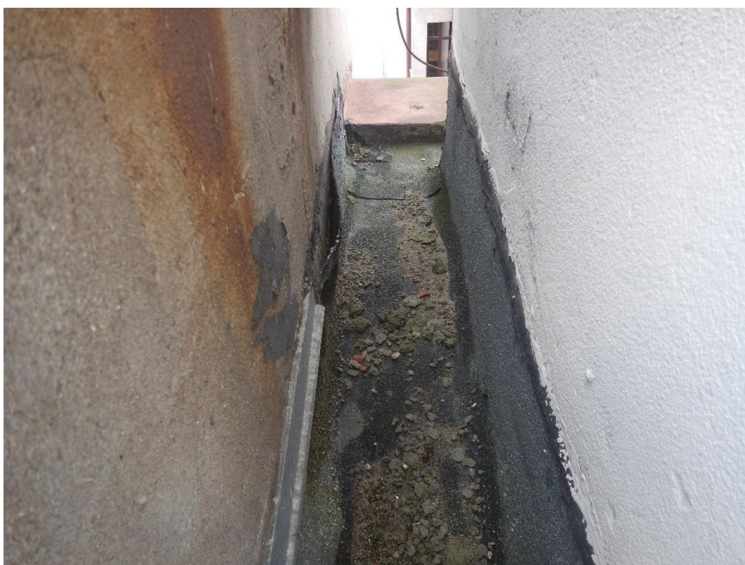
Fot.18 Dach płaski łącznika - przestrzeń między kominem a attyką
