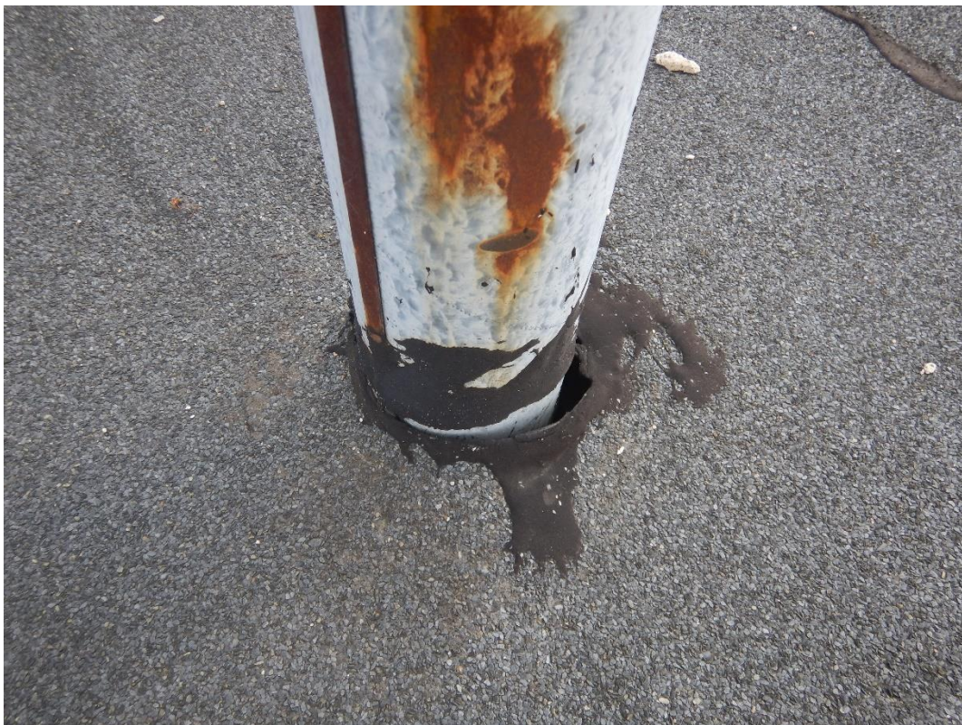
Fot.20 Dach płaski łącznika - obróbka kominka
