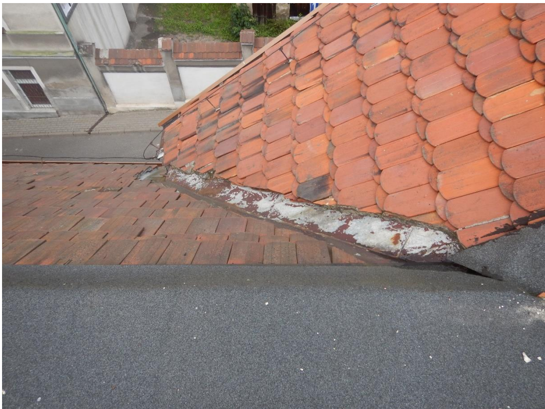
Fot.8 Dach łącznika – kosz
