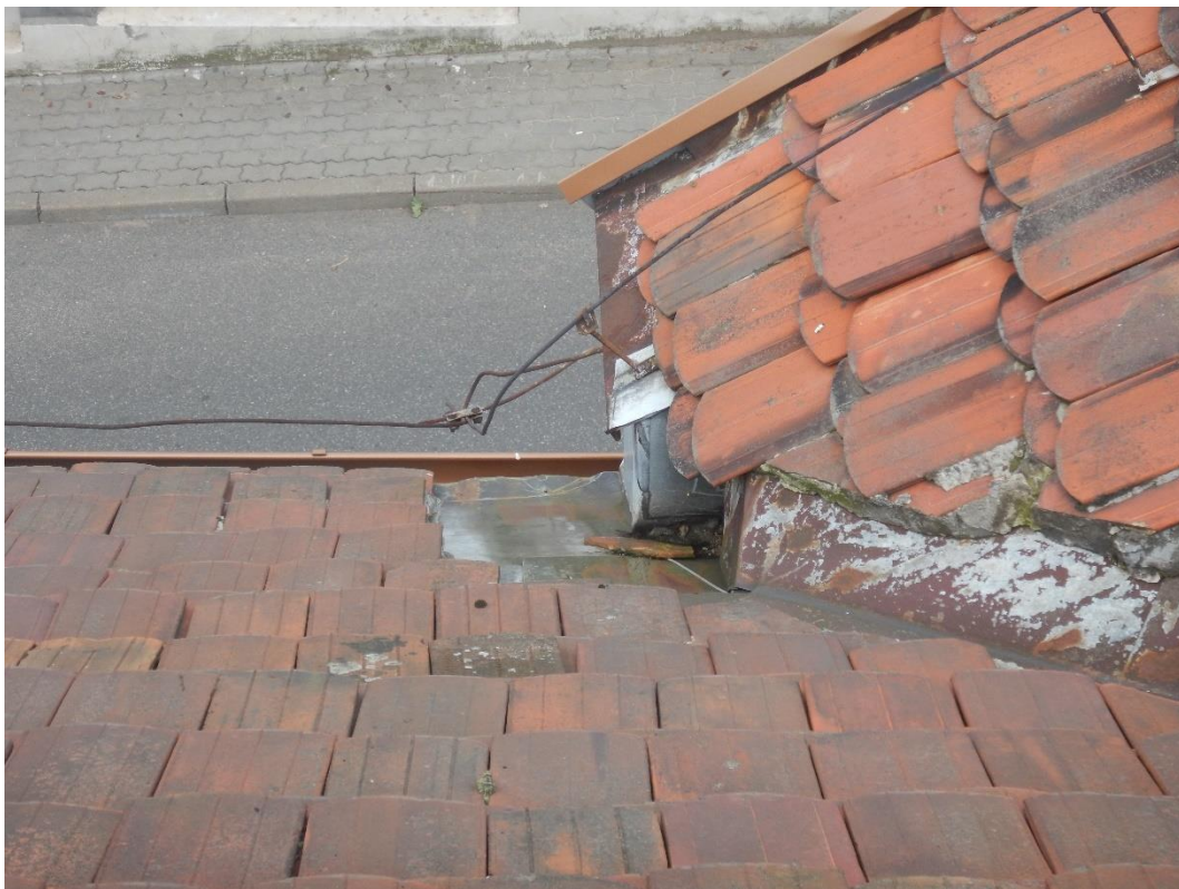
Fot.9 Dach łącznika - obróbka kosza
