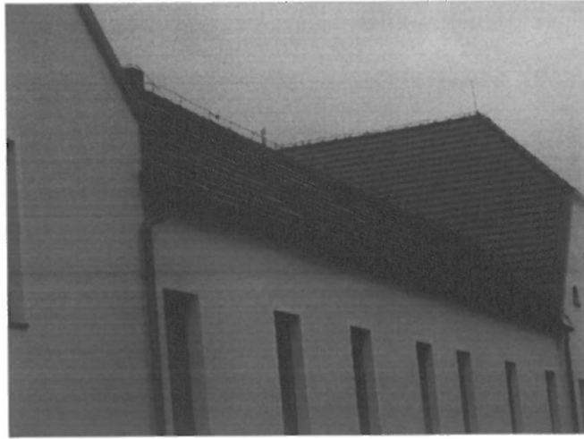
Dach od ulicy Garncarskiej.
