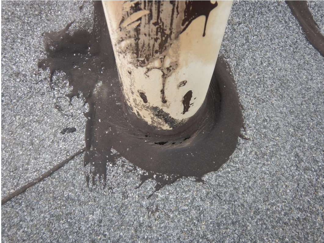
Fot.29 Dach płaski sali - obróbka kominka wentylacyjnego
