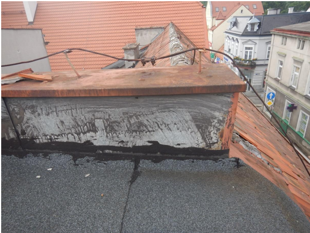
Fot.19 Dach płaski łącznika - obróbka attyki
