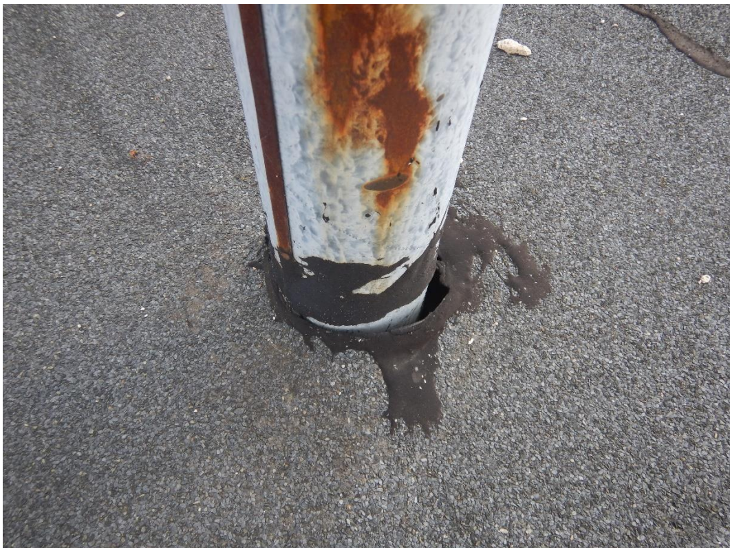
Fot.20 Dach płaski łącznika - obróbka kominka
