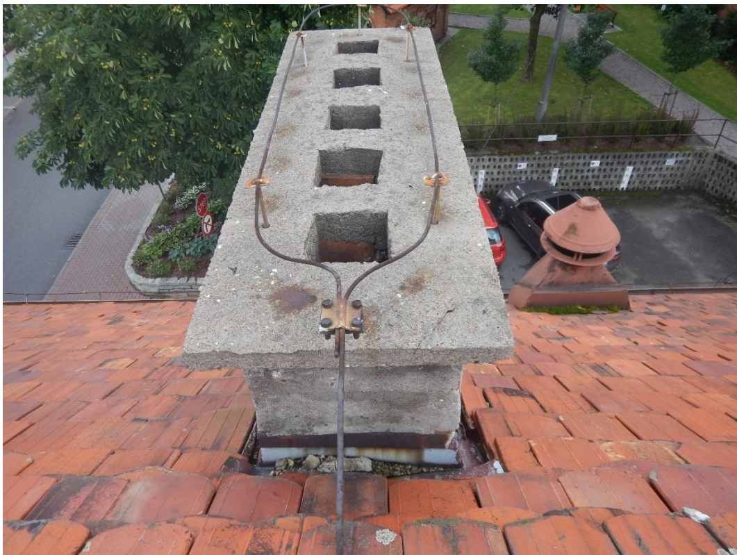
Fot.24 Dach stromy sali - obróbka komina
