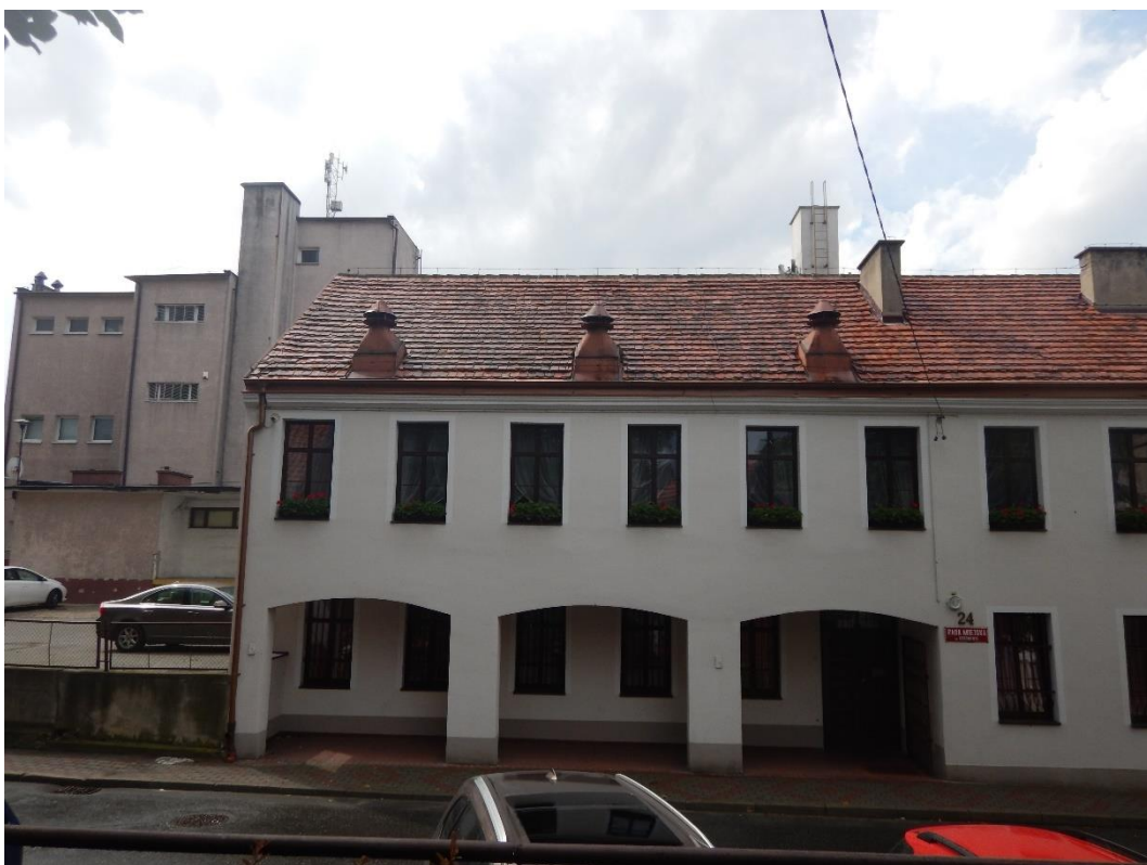
Fot.2 Elewacja budynku od ul. Farnej
