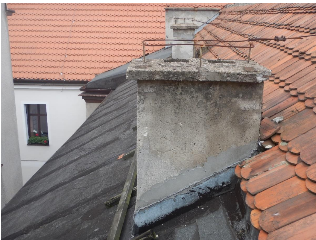
Fot.10 Dach łącznika - obróbka komina
