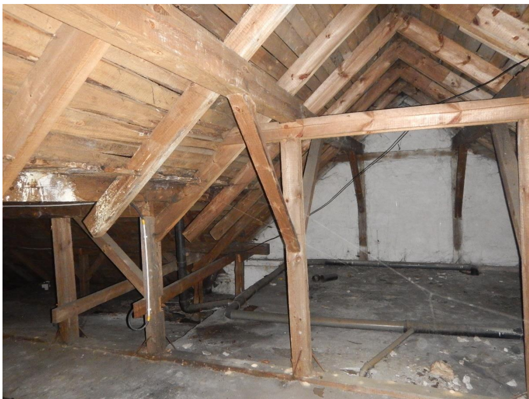
Fot.33 Dach sali - więźba drewniana
