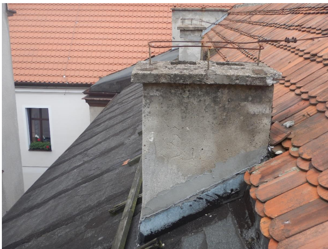
Fot.10 Dach łącznika - obróbka komina
