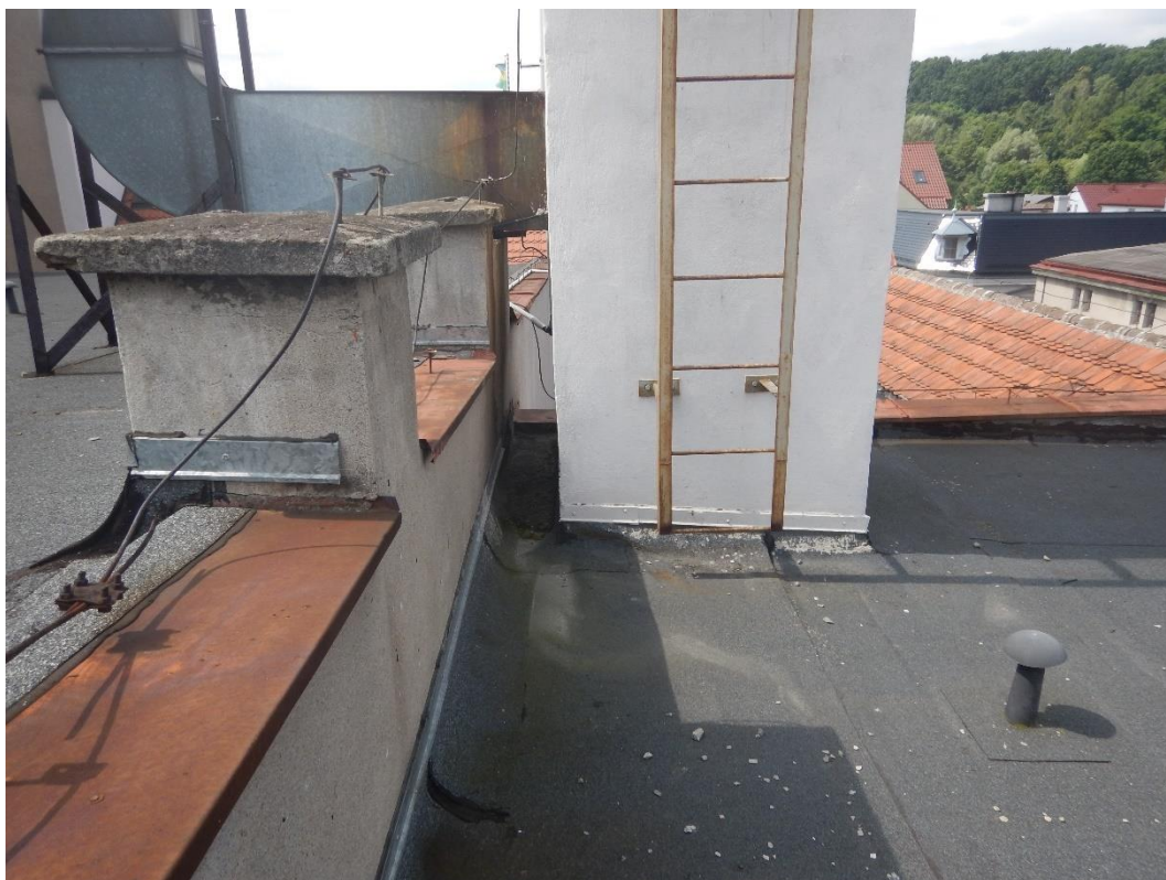
Fot.17 Dach płaski łącznika - attyka od strony południowej
