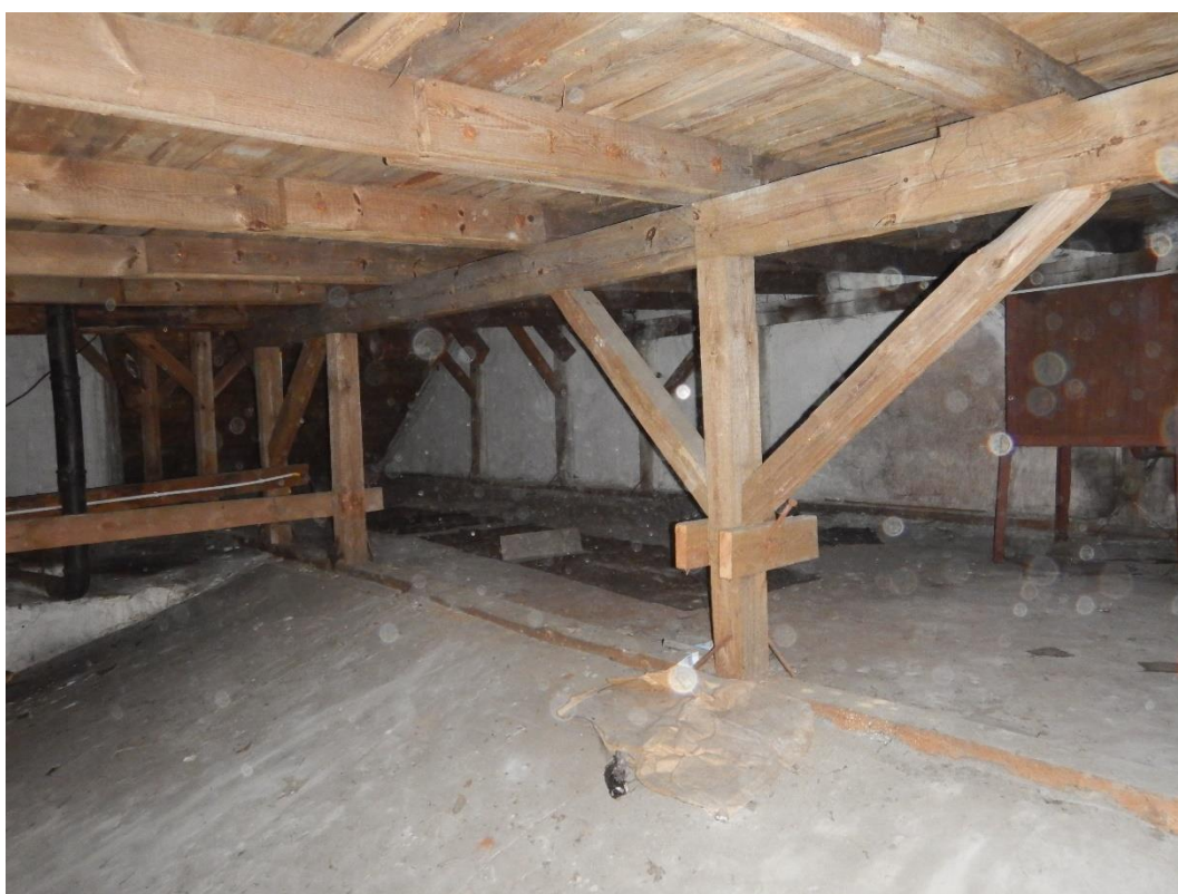
Fot.34 Dach płaski łącznika - więźba drewniana
