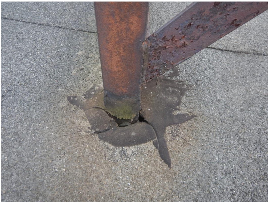
Fot.30 Dach płaski sali - obróbka konstrukcji wsporczej
