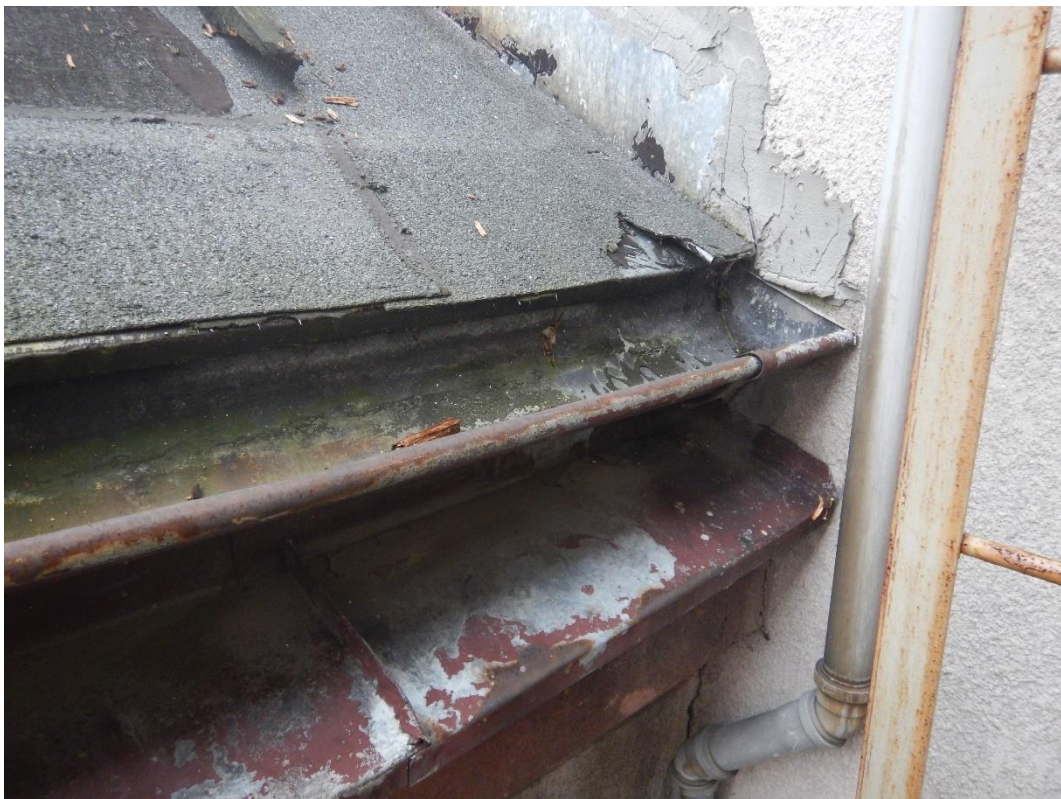
Fot.14 Dach łącznika - obróbka gzymsu od strony południowej
